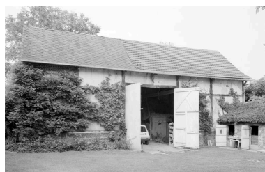
Grange. Elévation sur cour. Phot. Jean-Michel Perrin IVR22_19846001069X
