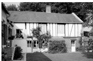
Moulin transformé en logement : élévation sur cour. Phot. Jean-Michel Perrin IVR22_19846001072X
