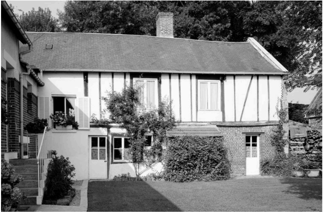
Moulin transformé en logement : élévation sur cour.
