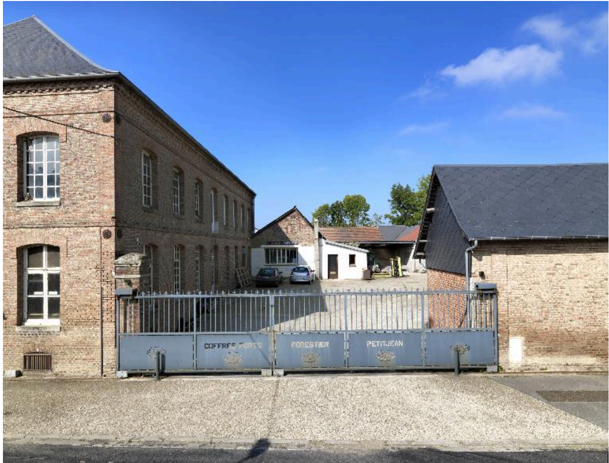
Bureaux, ateliers de fabrication et portail.
