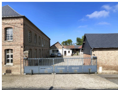
Bureaux, ateliers de fabrication et portail. Phot. Thierry Lefébure IVR22_20158000797NUC2A
