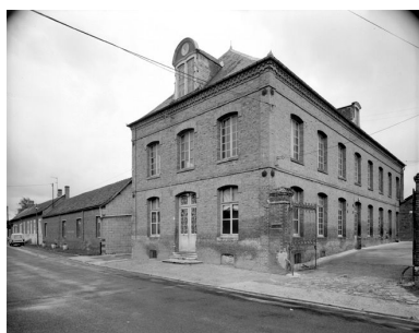
Atelier de fabrication, élévation antérieure, en 1988. Phot. Thierry Lefébure IVR22_19888001015V
