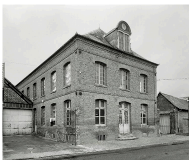
Elévation antérieure de l'usine et vue de l'atelier de fabrication, en 1990. Phot. Thierry Lefébure IVR22_19908001016V
