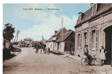
Le café de l'industrie à proximité immédiate de l'usine (coll. part.) Phot. Romain Grimaud (reproduction) IVR22_20138015751NUCA
