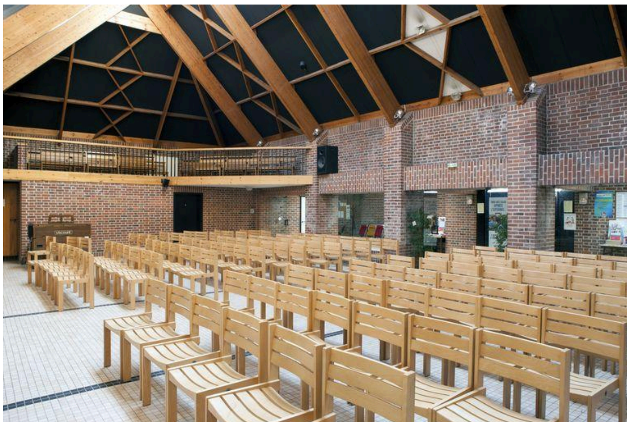
Vue de trois quart droit vers l'entrée.
