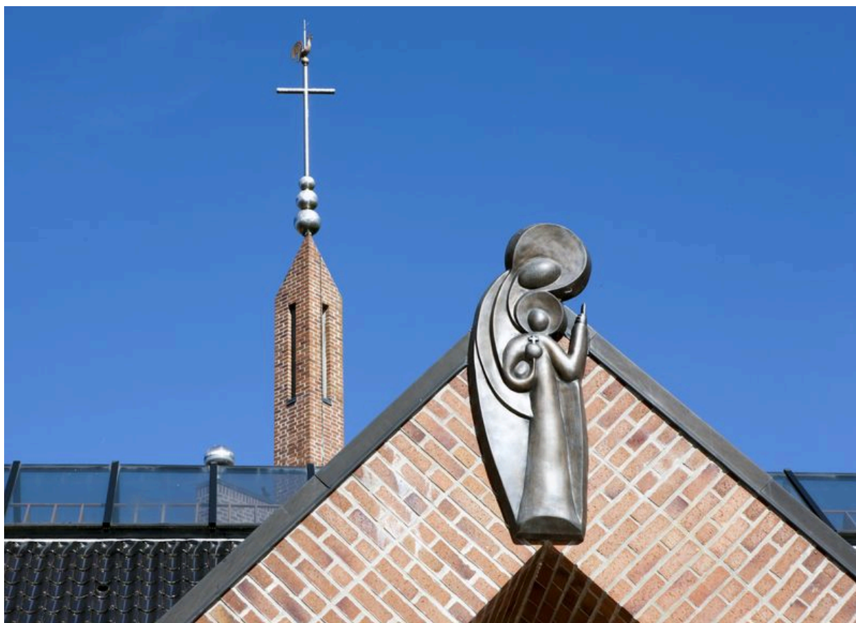
Partie supérieure de l'élévation antérieure.
