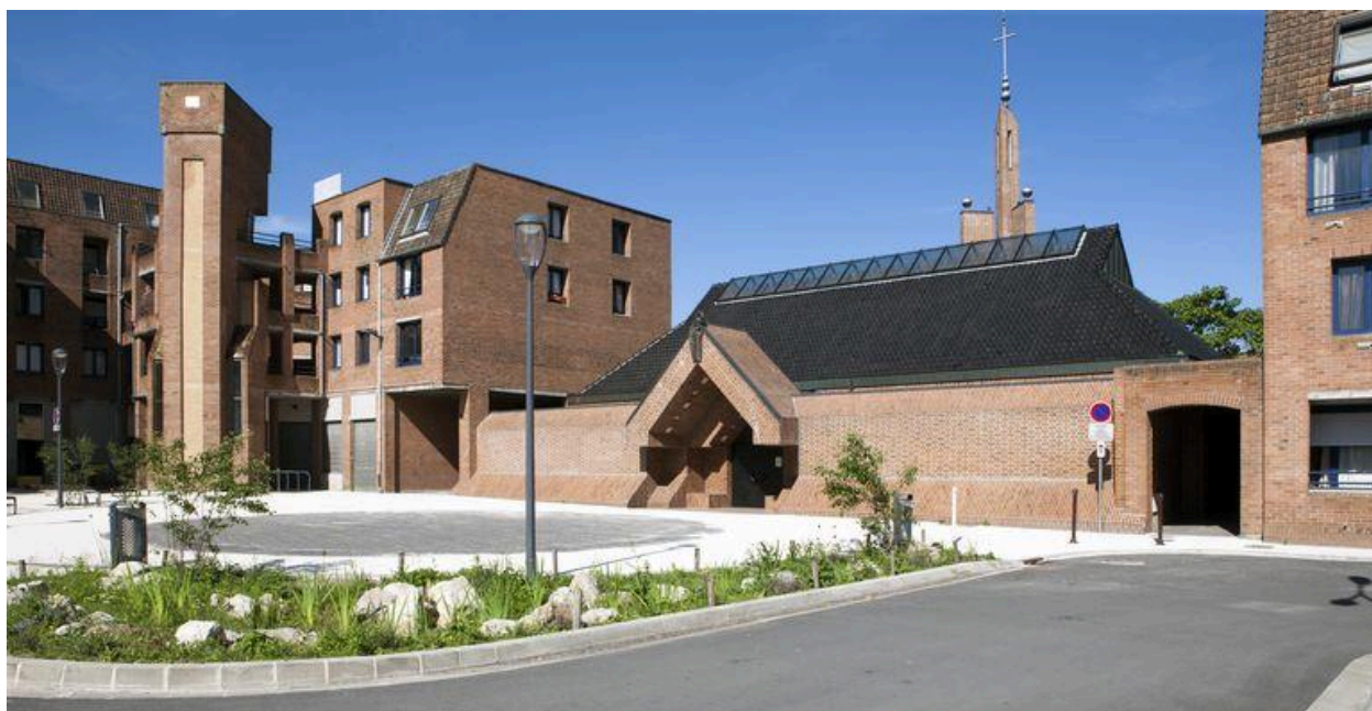
Vue de trois quart de l'élévation antérieure.
