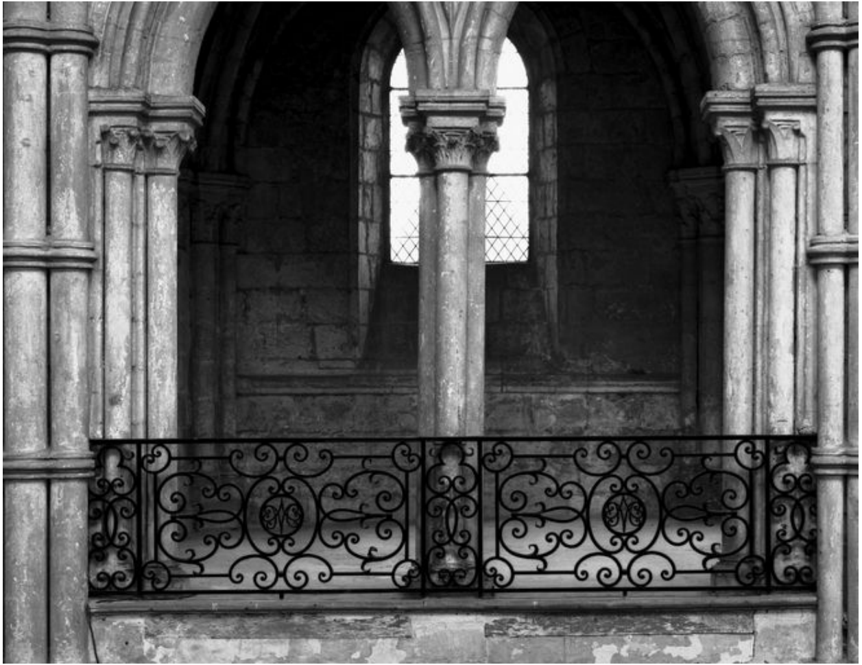
Vue d'un des garde-corps.
