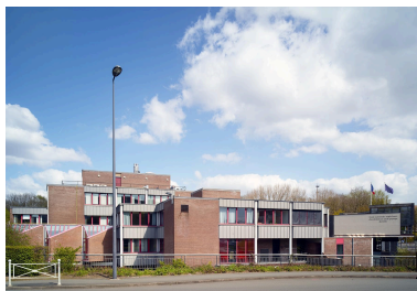
Façade sud de l'édifice initial, depuis le rond-point de la rue Verte. Phot. Pierre Thibaut IVR32_20185900388NUCA
