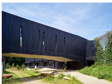
Couloir d'accès à la seconde extension, réalisée au nord (vue vers le nord). Phot. Pierre Thibaut IVR32_20195900139NUCA
