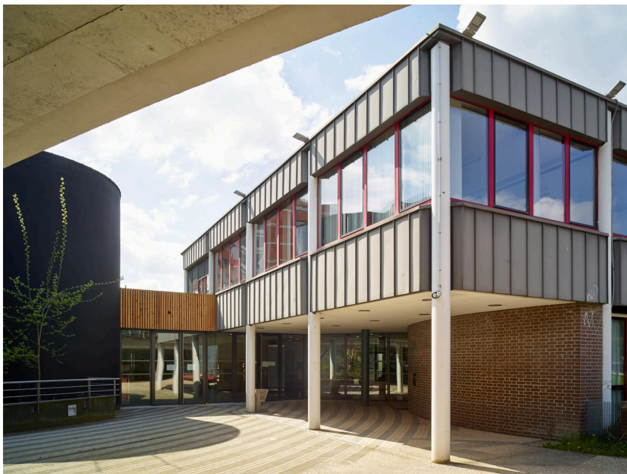
L'entrée et l'édifice initial (à droite), au nord-est.
