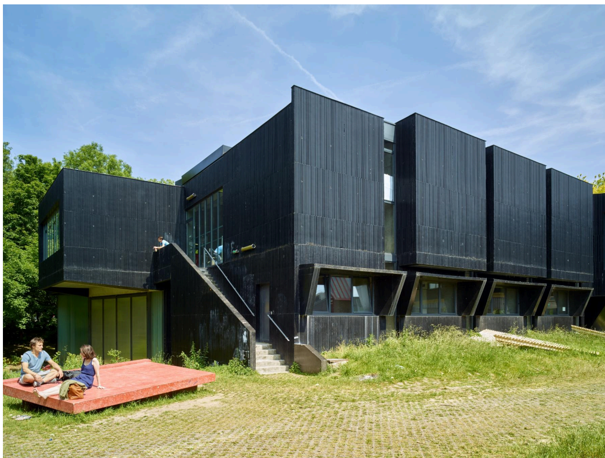
La seconde extension, réalisée au nord de la parcelle (vue depuis le nord-ouest).
