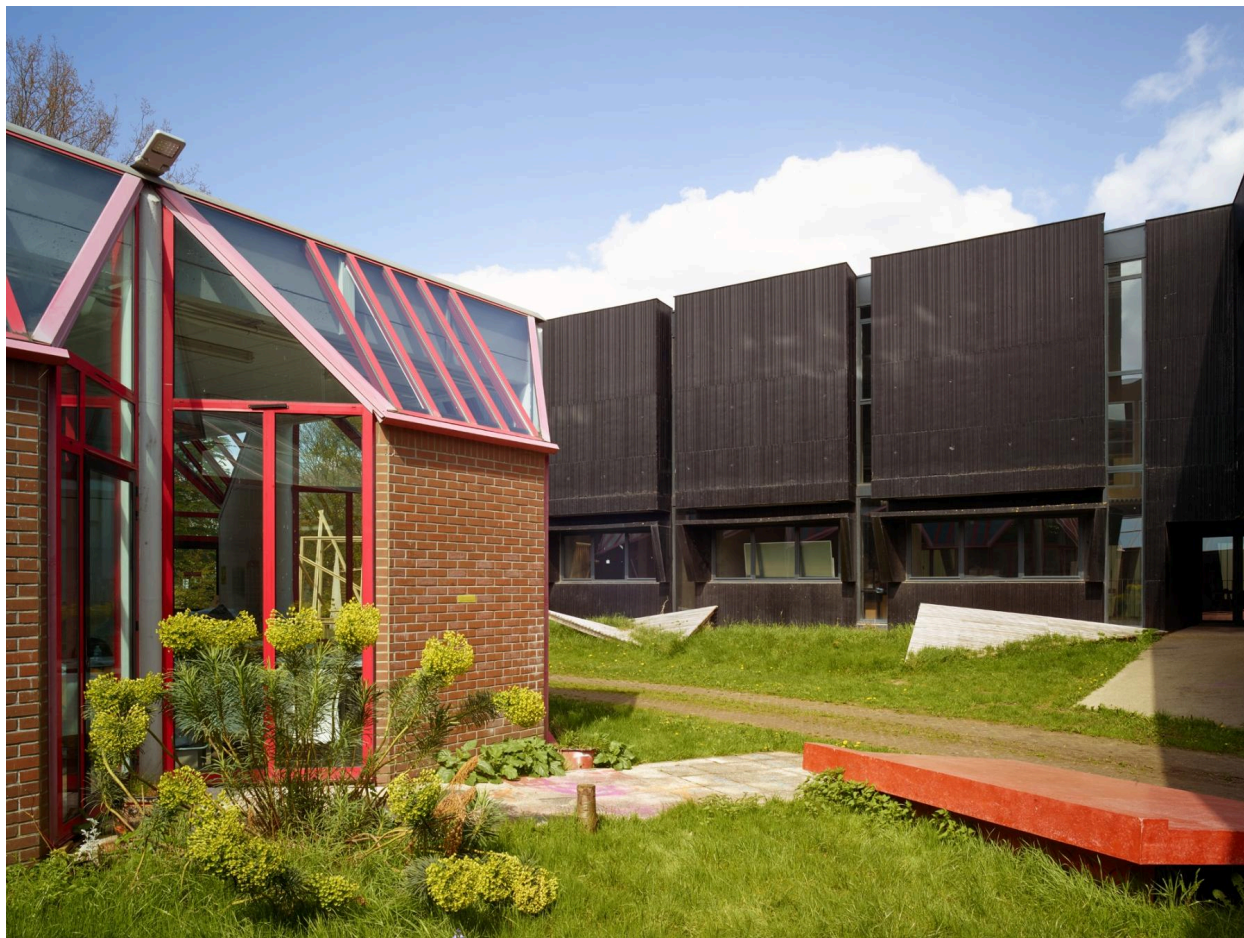
Vue d'un espace de détente, entre le bâtiment initial (à gauche) et la seconde extension, réalisée au nord.
