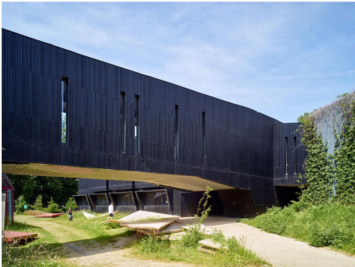
Couloir d'accès à la seconde extension, réalisée au nord (vue vers le nord).
