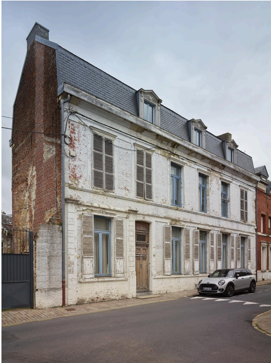
Ancienne école privée : façade avant, vue orientée ouest - est.
