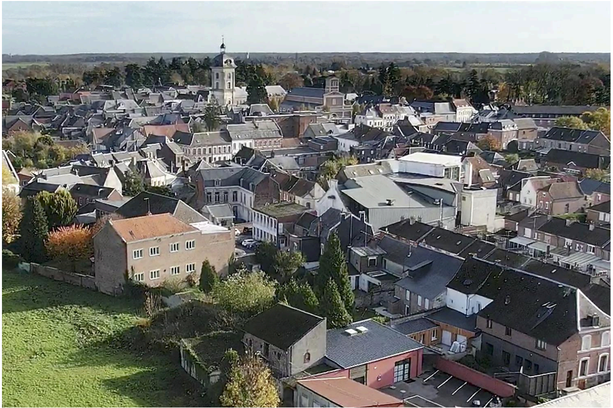
Façade arrière des deux ailes de l'ancienne école privée (bâtiment blanc au centre de l'image formant un L).
