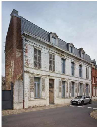
Ancienne école privée : façade avant, vue orientée ouest - est. Phot. Pierre Thibaut IVR32_20245900374NUCA
