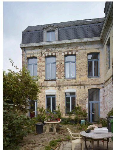
Ancienne école privée : façade arrière de l'aile en retour d'équerre. Phot. Pierre Thibaut IVR32_20245900375NUCA
