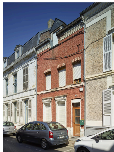
Ancienne maison des instituteurs de l'école de Mmes Coquelet et Mortier - 20, rue Baillon. Phot. Pierre Thibaut IVR32_20255900497NUCA
