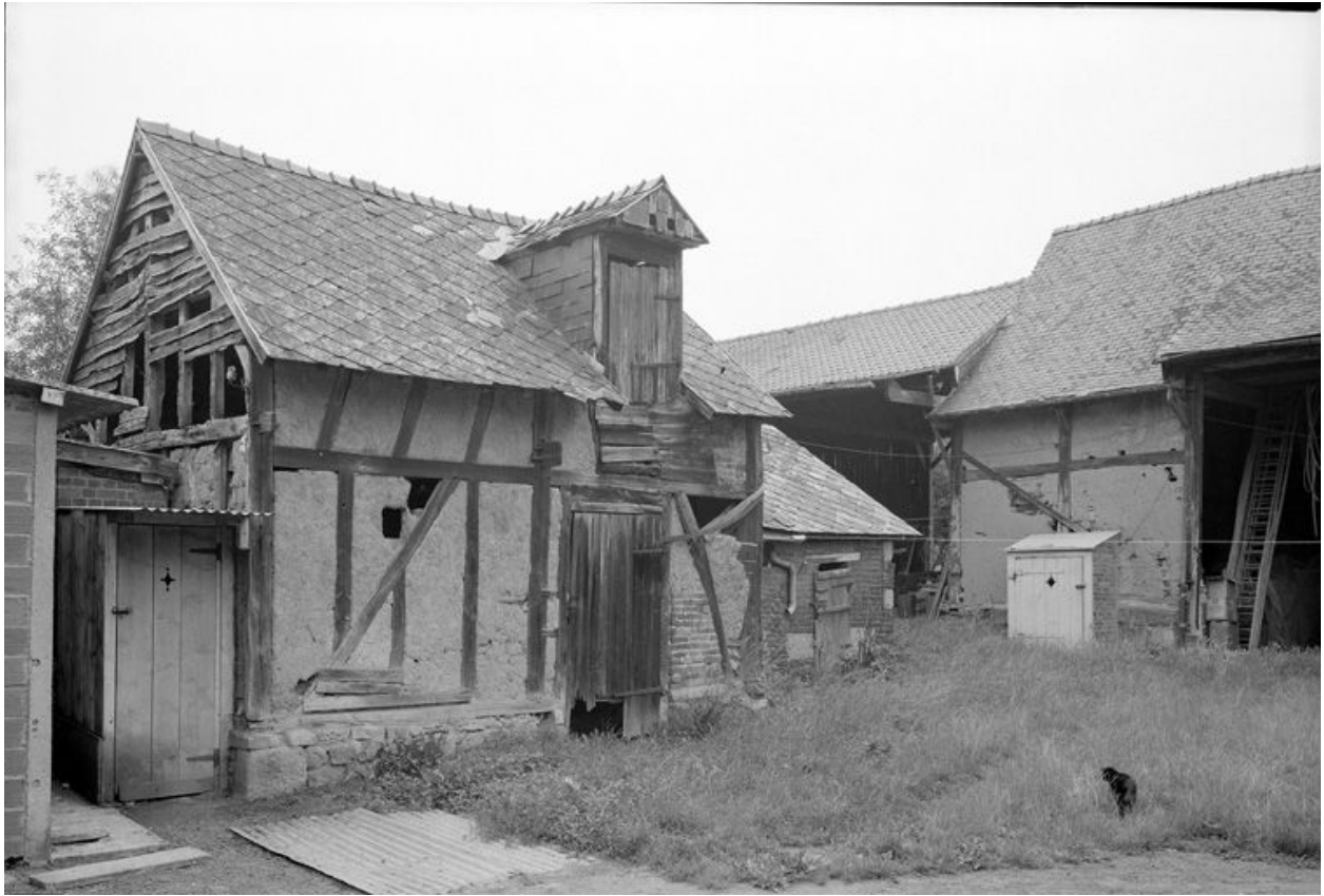
Bâtiments d'exploitation. Vue générale.
