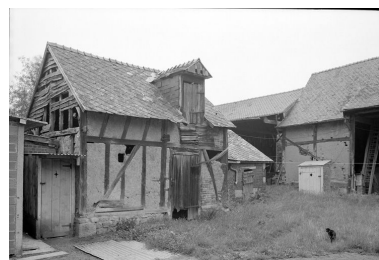
Bâtiments d'exploitation. Vue générale. Phot. Jean-Michel Perrin IVR22_19846000993X
