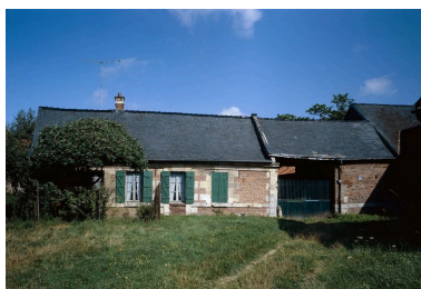
Élévation antérieure. Phot. Jean-Michel Perrin IVR22_19846001124XA
