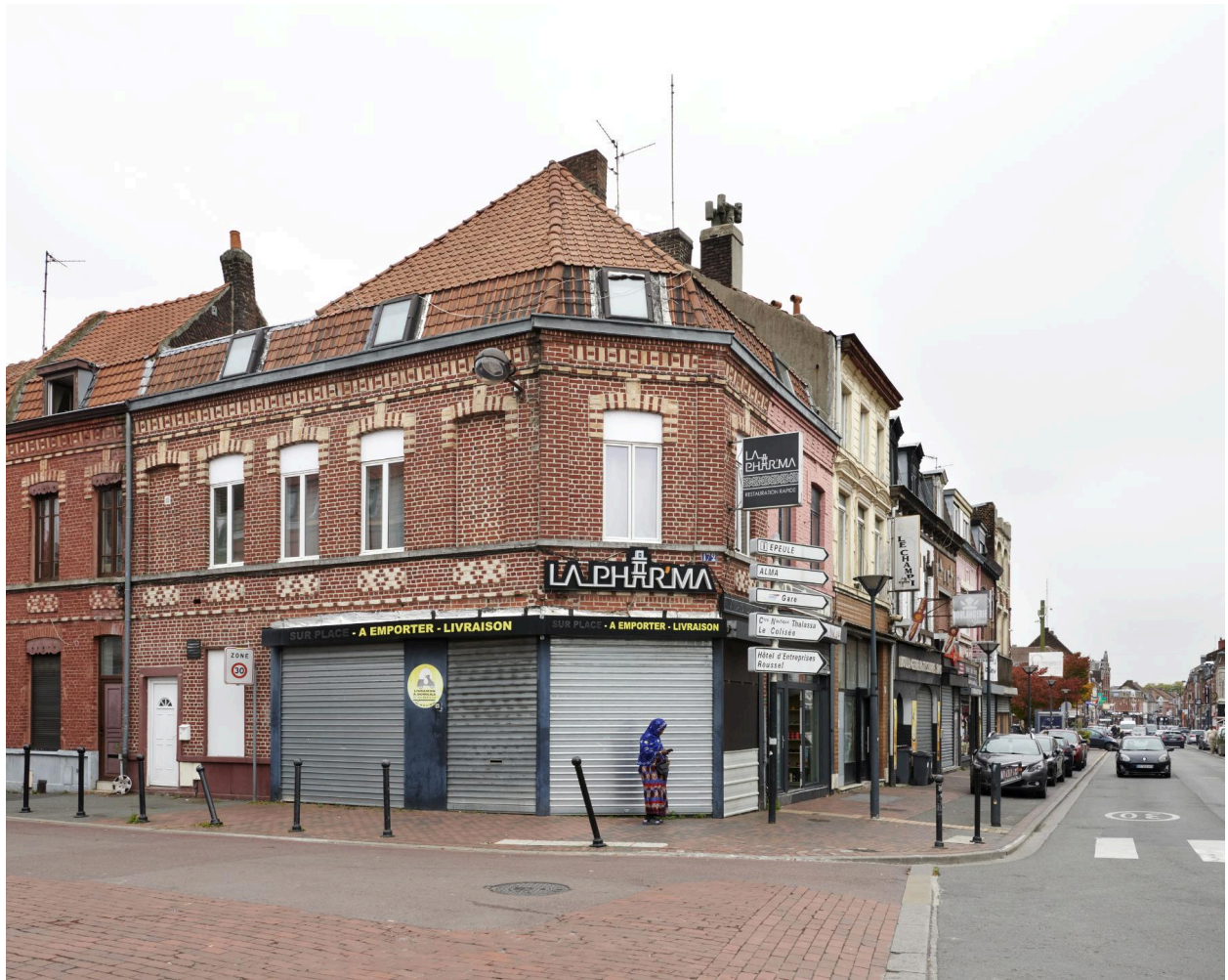
Rang de maisons à 2 travées en angle sur rue de l'Epeule, appareillage en plate bande, frise sous la corniche.
