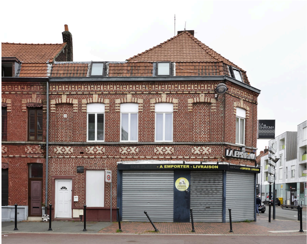
Maisons à 2 travées en angle sur rue de l'Epeule, appareillage en plate bande, frise sous la corniche.
