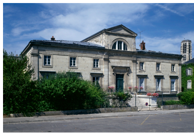
Vue générale depuis la place des Etats-Unis. Phot. Thierry Lefébure IVR22_19940200783XA
