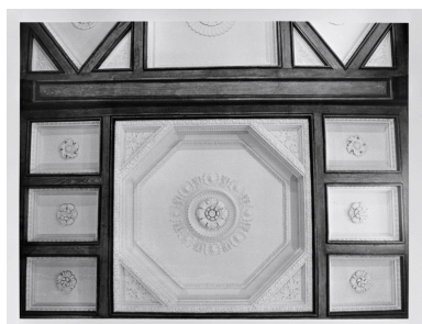
Le plafond de la salle d'audience en 1976 (cliché CRMH).
