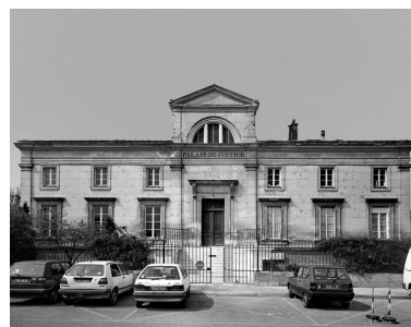
Vue de la façade sur la place des États-Unis.
