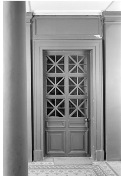
Une des portes intérieures donnant sur la salle des pas perdus. Phot. Thierry Lefébure IVR22_19940201195X
