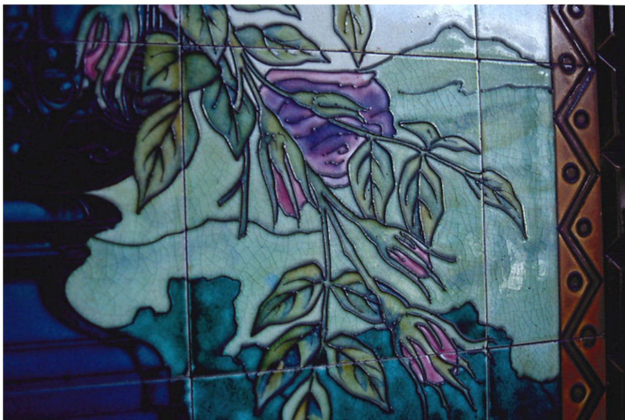
Porche : décor de céramique à droite en entrant, détail de mise en œuvre.
