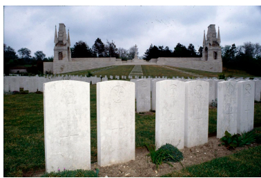
Vue générale de la terrasse faisant face à la nécropole. Phot. Philippe Dapvriil IVR31_19906200100ZA
