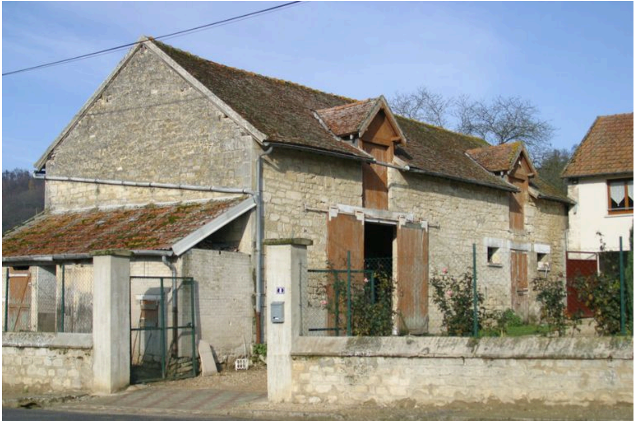
Vue de la grange.
