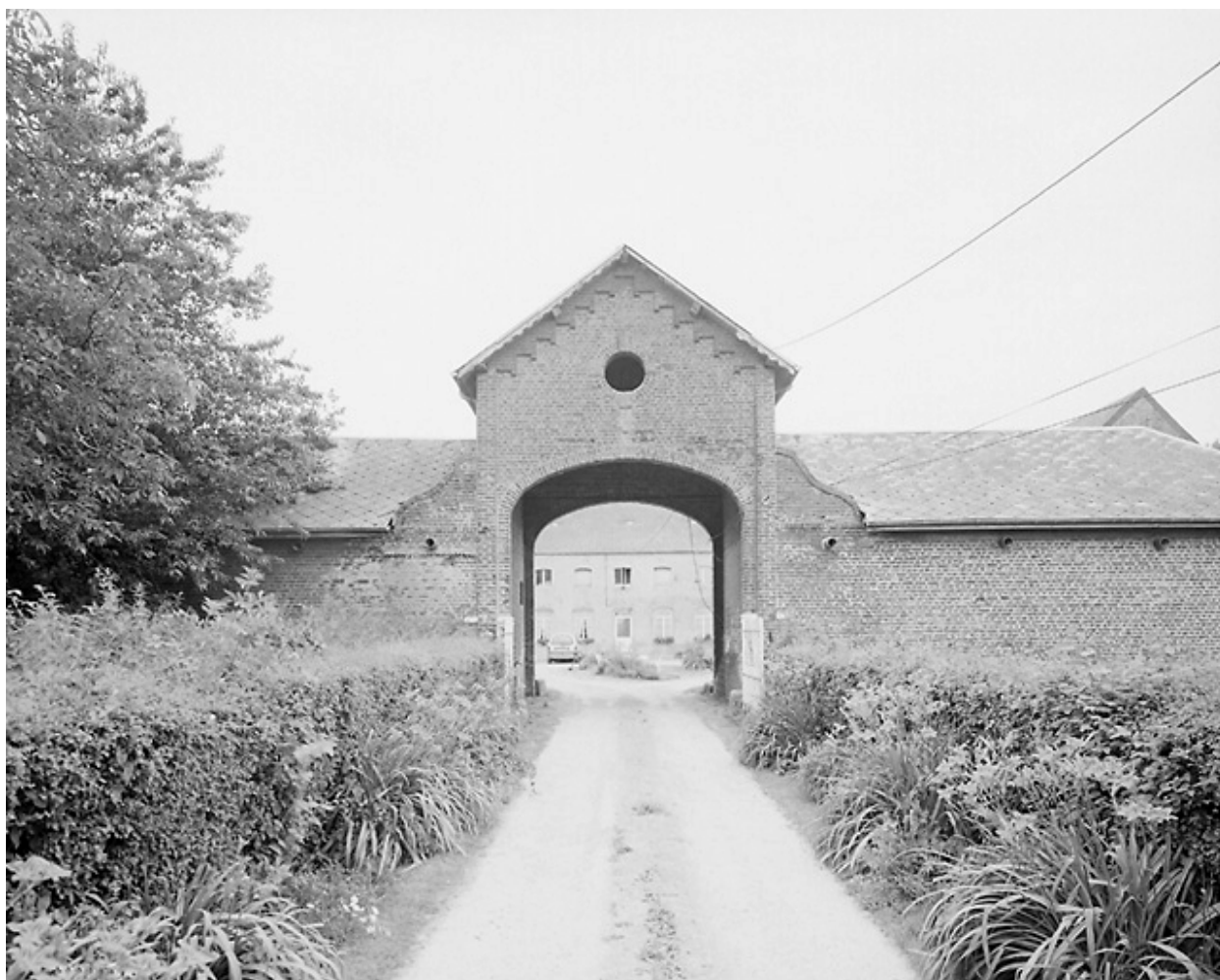
Vue générale du porche d'entrée.
