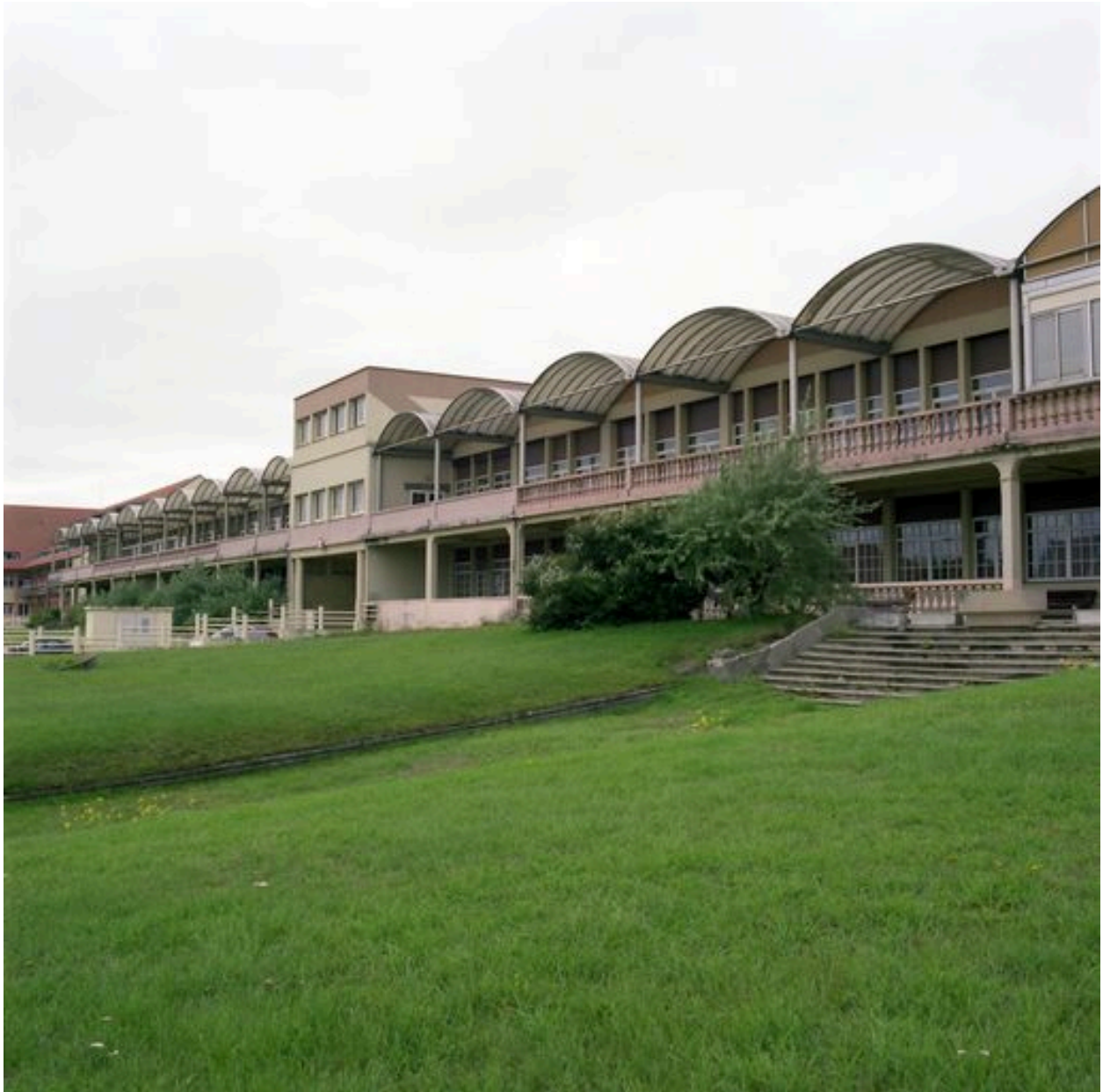
Bâtiments A et B, élévations antérieures, vue d'ensemble prise de trois-quarts droit.
