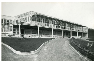
Bâtiment affecté aux femmes dit Institut hélio-marin B, élévation antérieure, vue générale prise
