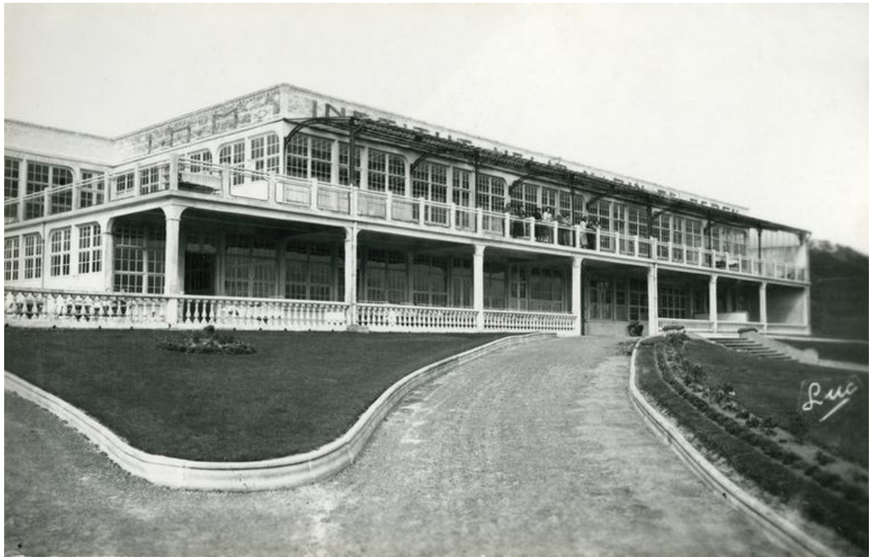
Bâtiment affecté aux femmes dit Institut hélio-marin B, élévation antérieure, vue générale prise de trois-quarts gauche. Carte postale, milieu du 20e siècle.
