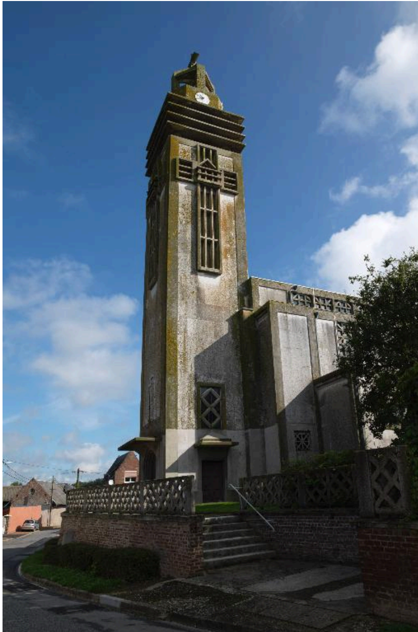
Vue du clocher-porche, depuis le sud.
