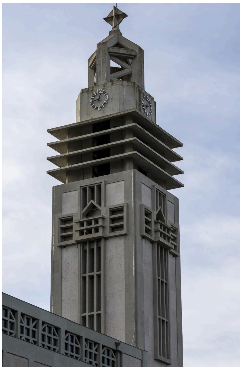
Vue de détail de la tour-clocher.
