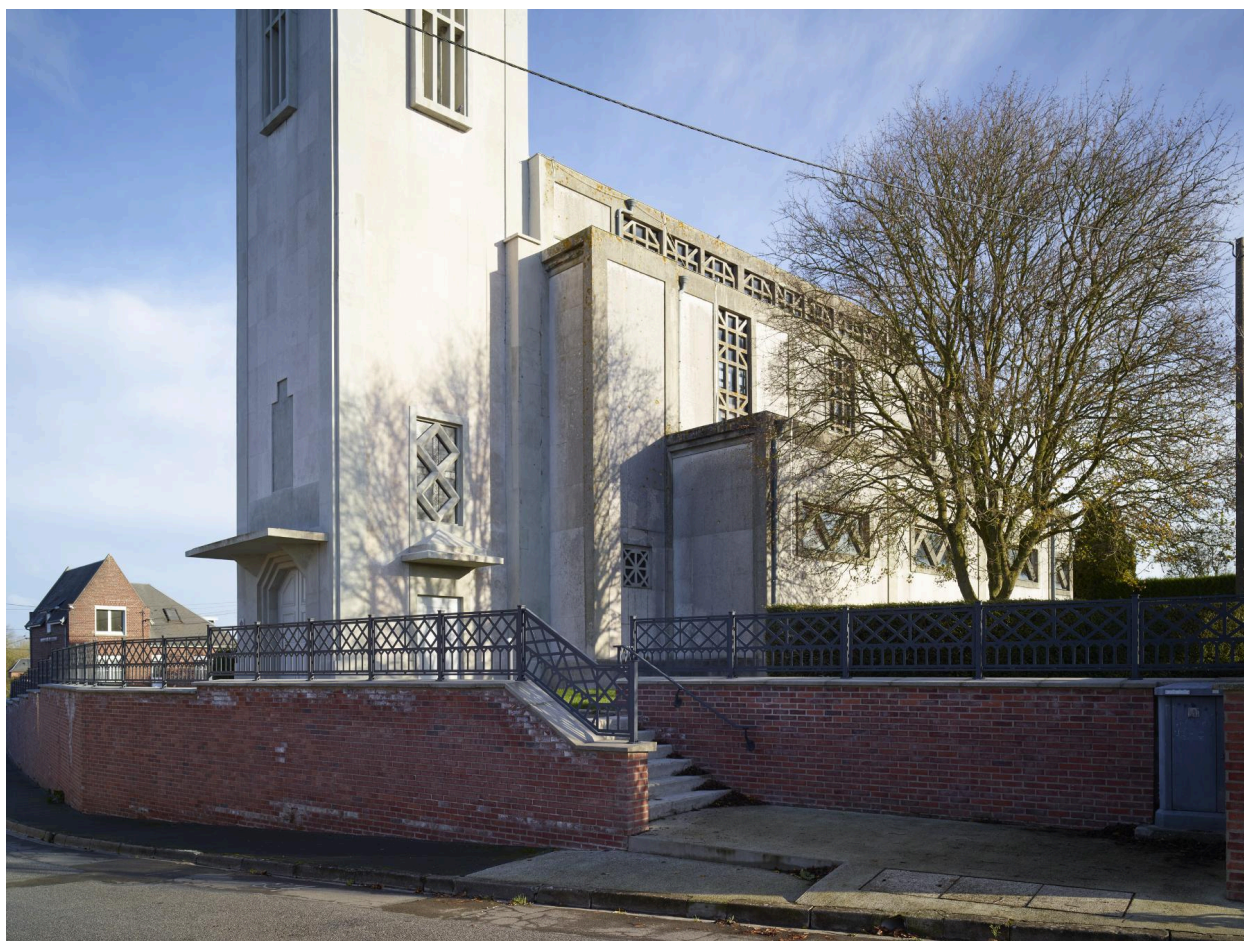
Vue de l'entrée de l'église, côté sud.
