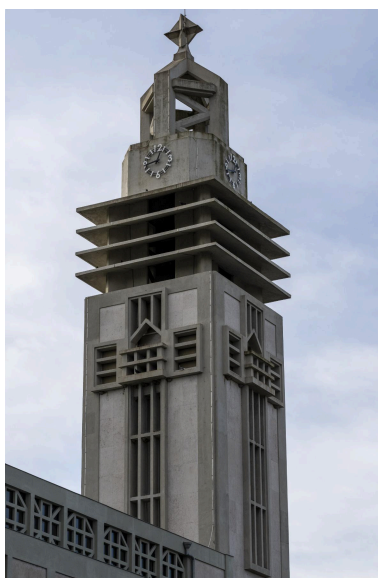
Vue de détail de la tour-clocher. Phot. Pierre Thibaut IVR32_20258002304NUCA
