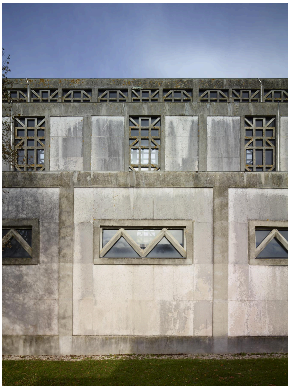
Détail de l'élévation sud.
