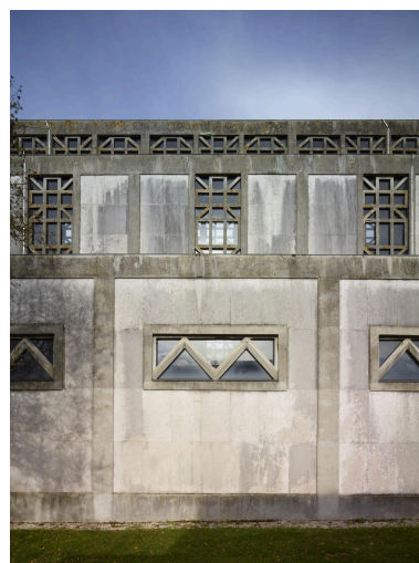
Détail de l'élévation sud. Phot. Pierre Thibaut IVR32_20258002332NUCA
