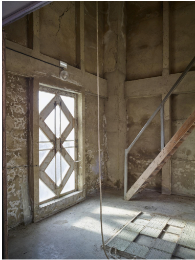
Verrière et escalier de la tour-clocher.
