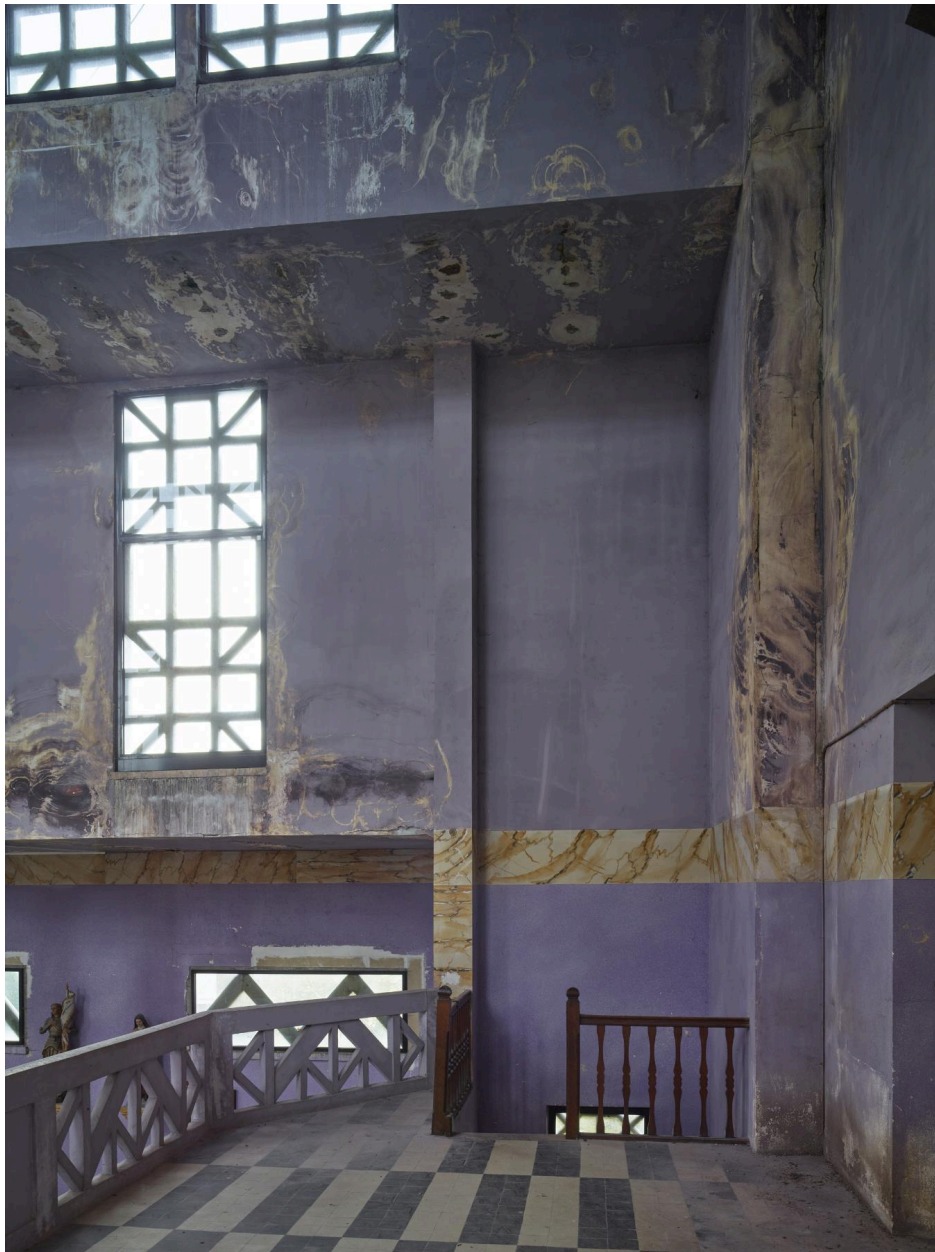
Vue du mur sud, depuis la tribune.
