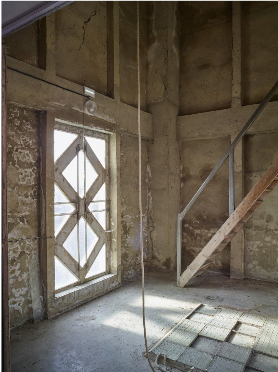
Verrière et escalier de la tour-clocher.
