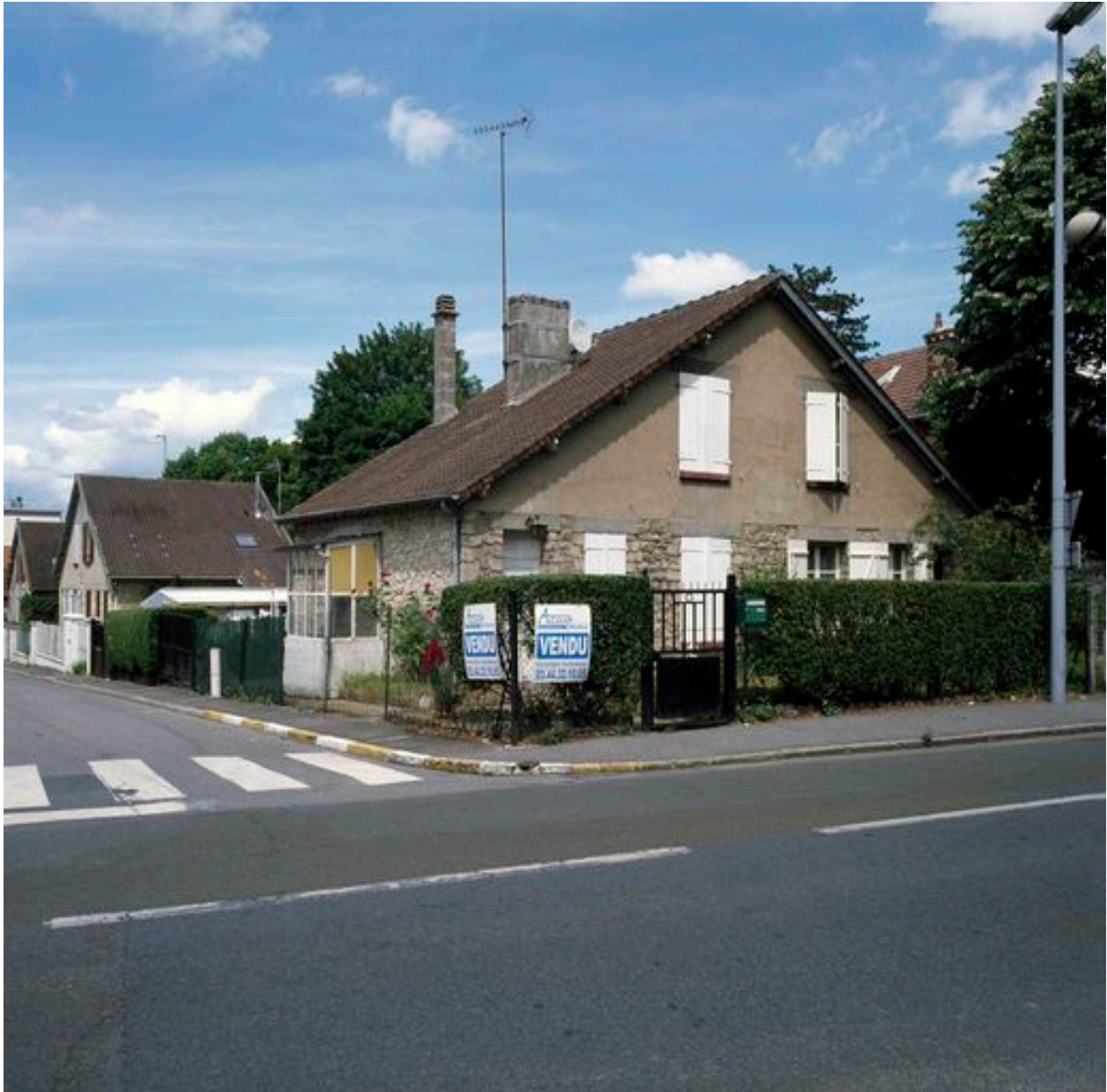
Cité Claude-Primet depuis la rue Louis-Boilet.
