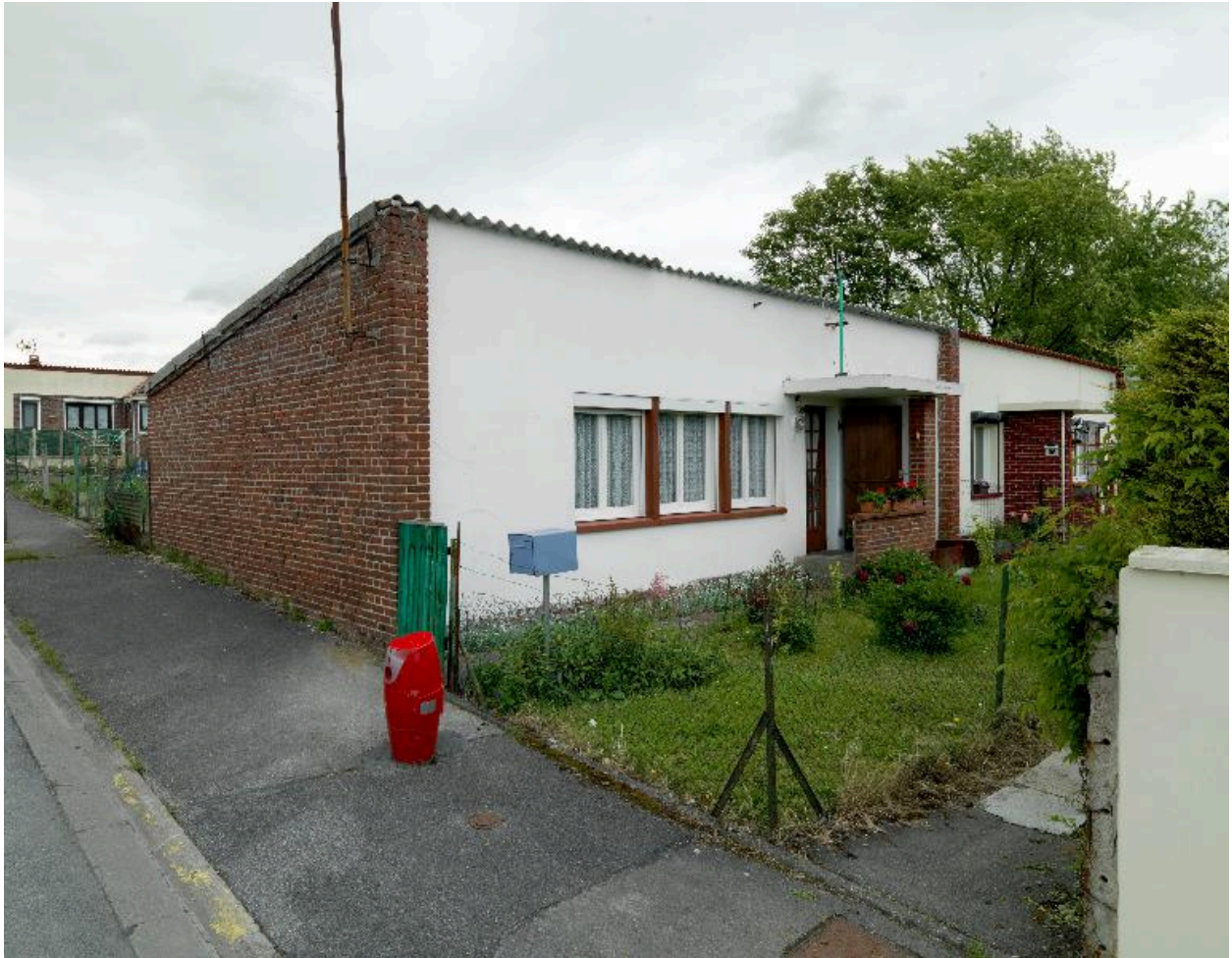
Vue d'un des logements de la cité.
