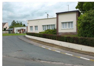
Logement avec boucherie et garage à l'entrée de la cité des Castors. Phot. Thierry Lefébure IVR22_20128000330NUC2A
