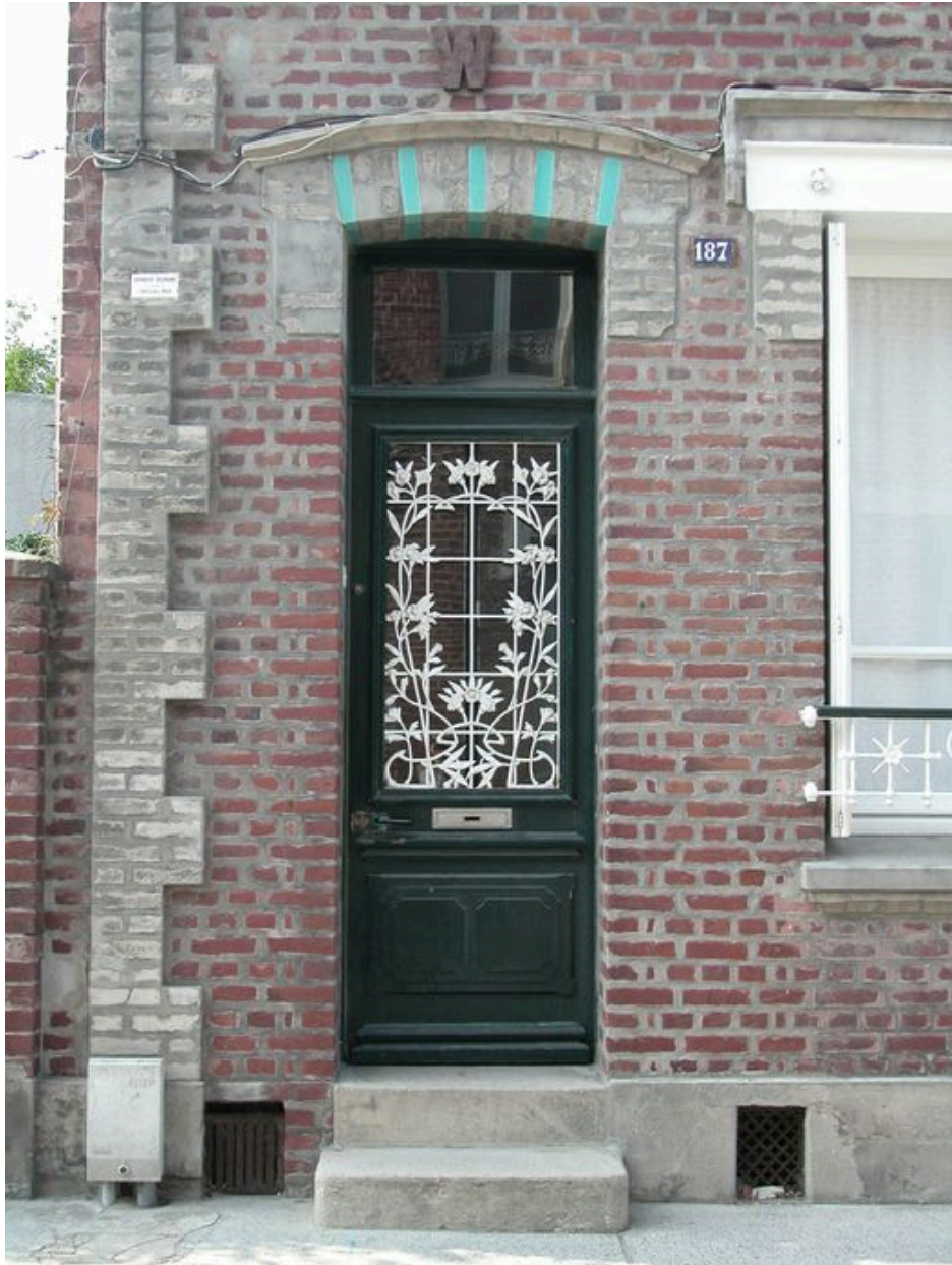
Détail de la porte et de sa grille en fonderie.
