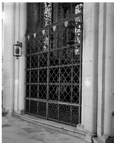
Chapelle du Saint Sacrement, actuellement du Saint Sang : clôture, vue générale fermée.
