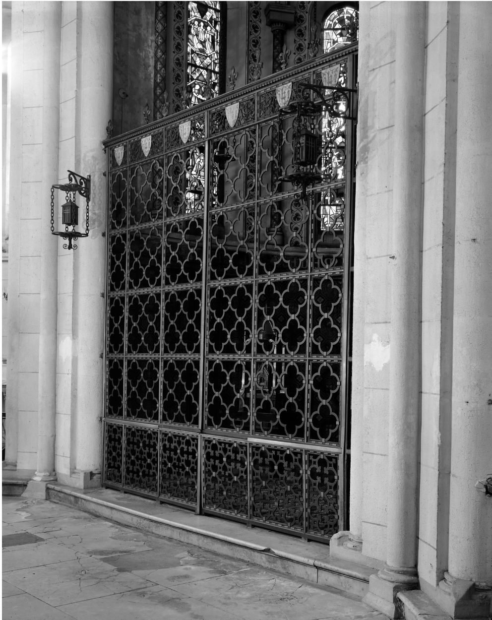
Chapelle du Saint Sacrement, actuellement du Saint Sang : clôture, vue générale fermée.
