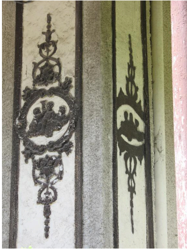
Décor des pilastres de la façade. Phot. Bertrand Fournier IVR22_20088015516NUCA
