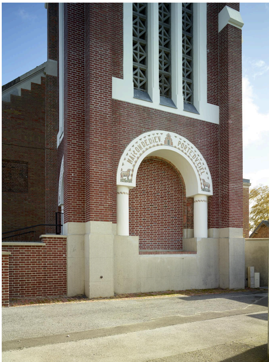
Vue de détail des deux premiers niveaux du clocher-porche côté ouest, avec les claustras en béton.
