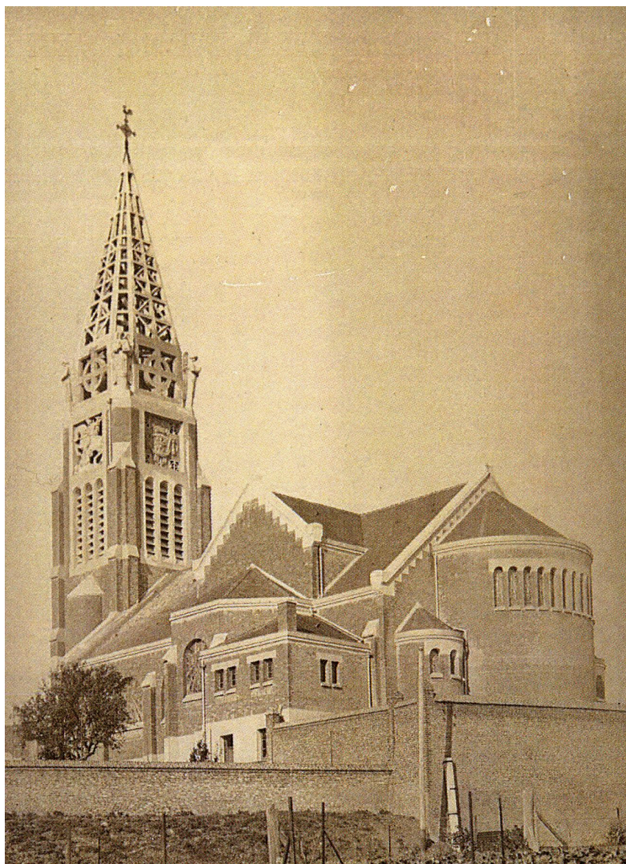
Façade sud de l'église en 1929. Photographie prise par l'architecte (A diocésaines Cambrai, 7L 01.75).
