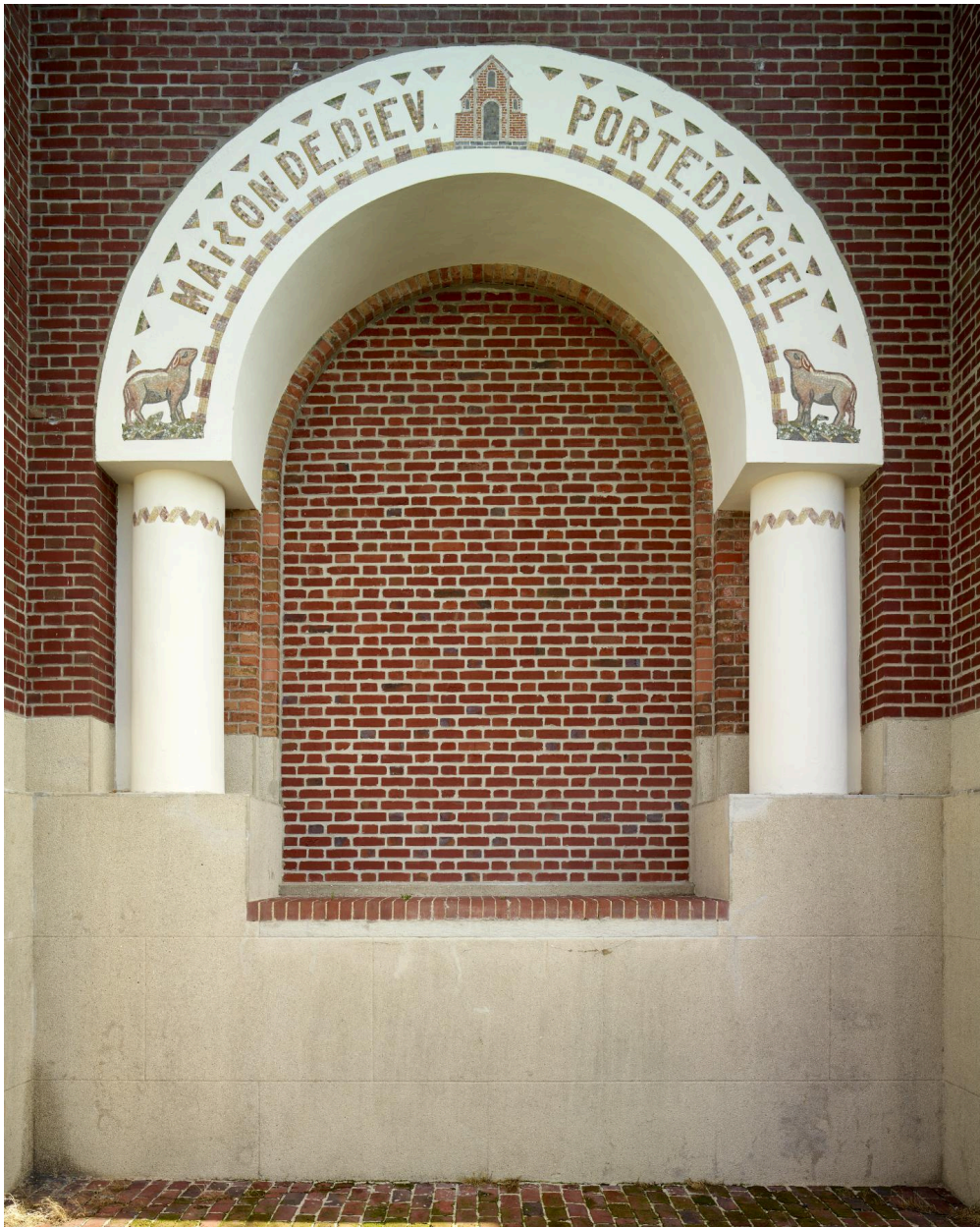
Vue de détail de l'arc aveugle du premier niveau du clocher-porche côté ouest.
