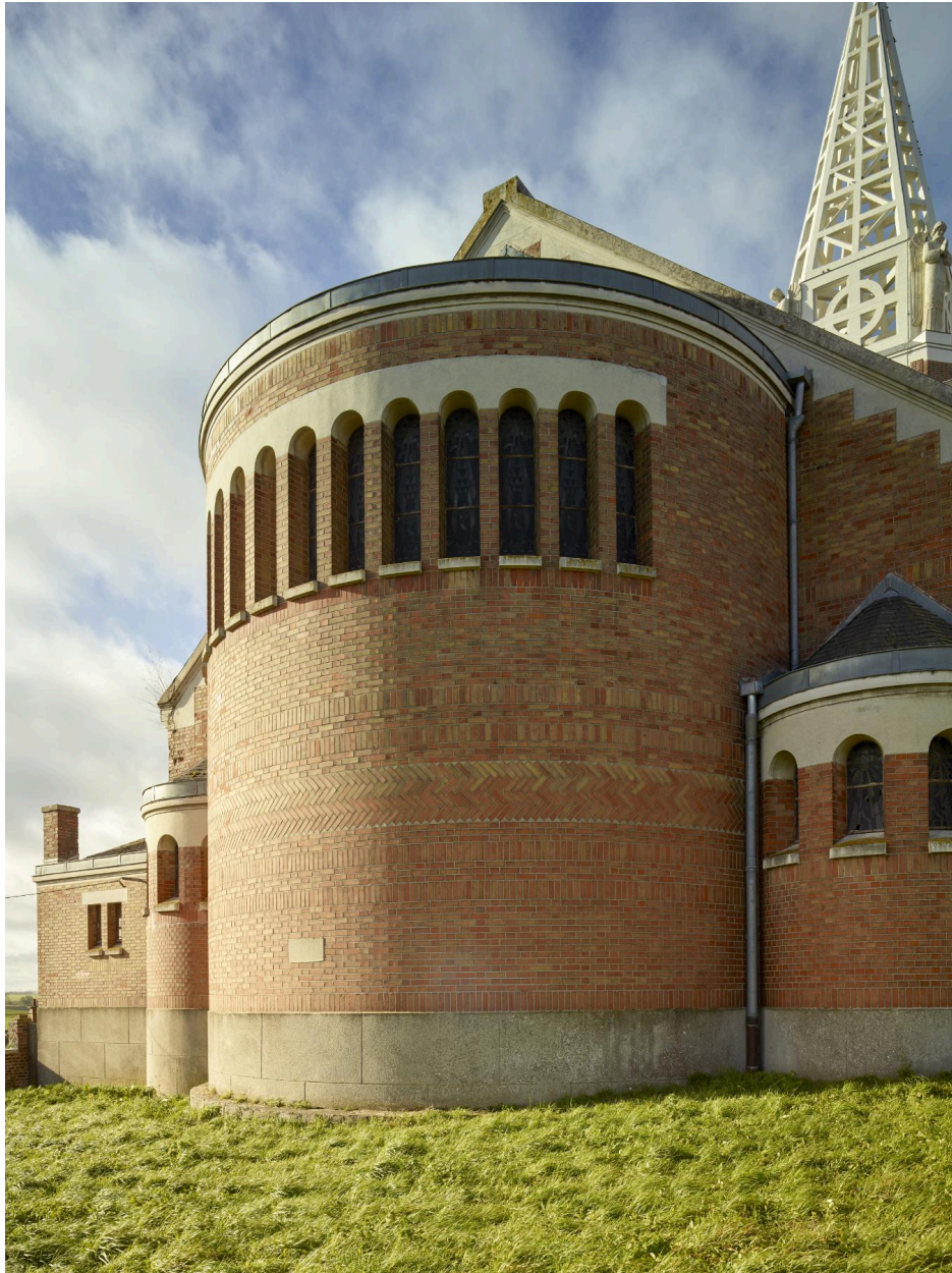
Chevet avec détail des calepinages de briques.
