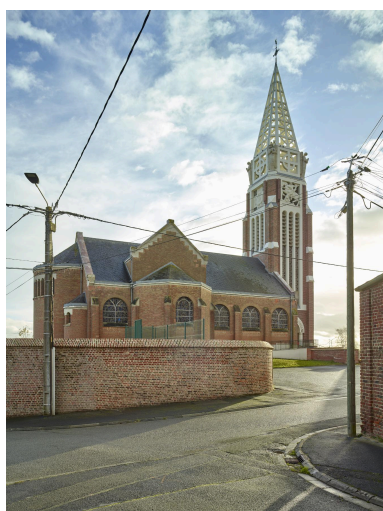
Vue générale de l'église avec le clocher-porche et le mur nord. Vue orientée est - ouest. Phot. Pierre Thibaut IVR32_20235900935NUCA
