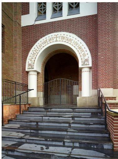
Vue de détail de l'arc du premier niveau du clocher-porche côté nord. Phot. Pierre Thibaut IVR32_20235900938NUCA
