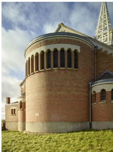
Chevet avec détail des calepinages de briques. Phot. Pierre Thibaut IVR32_20235900925NUCA
