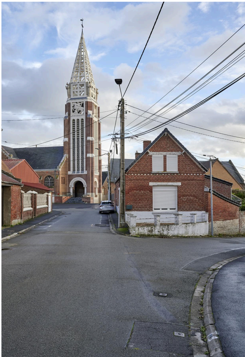
Église Saint-Martin de Fontaine-Notre-Dame : vue de situation depuis la rue de la Liberté. Vue orientée nord - sud.
