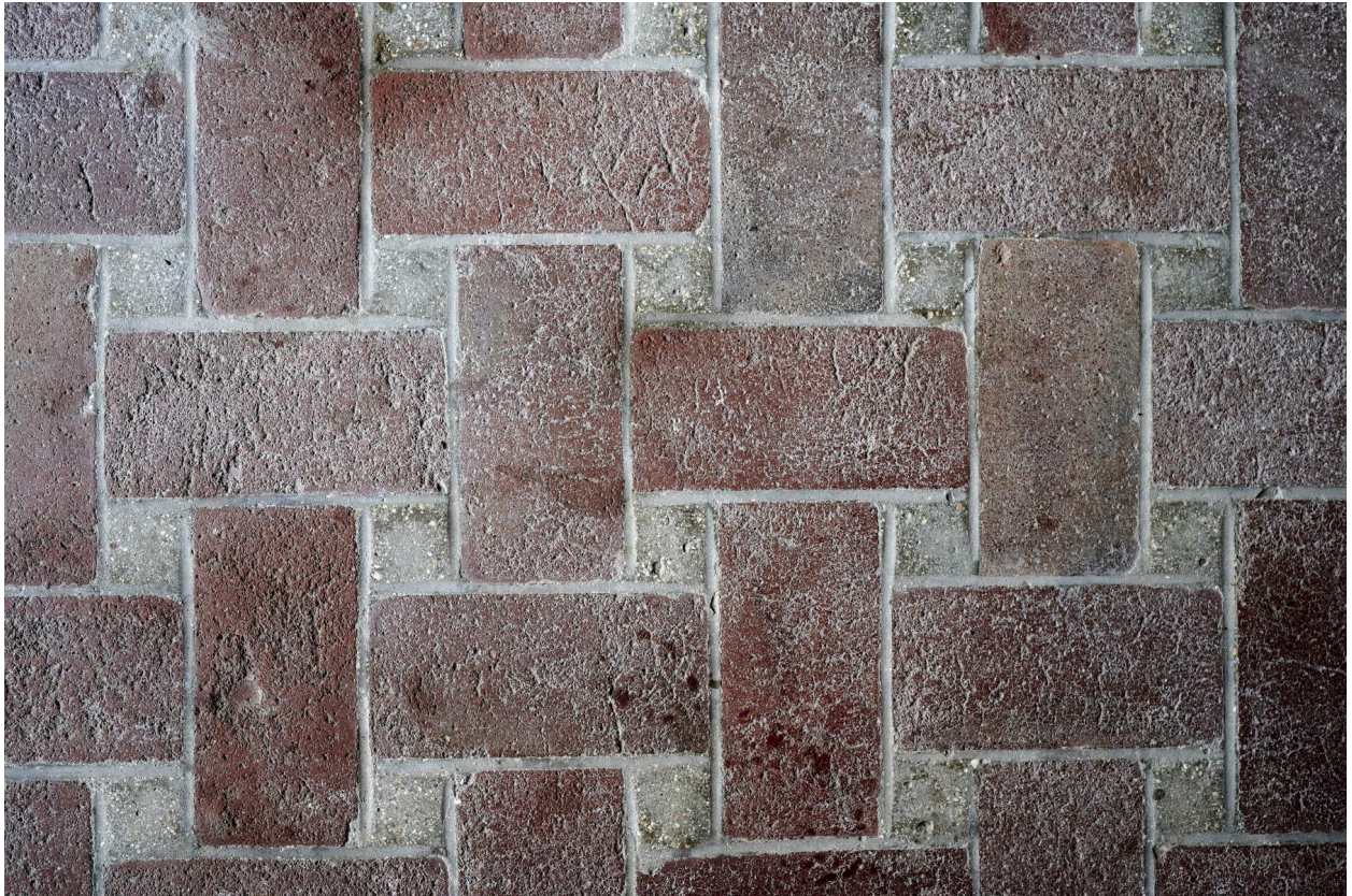
Vue de détail du calepinage de brique, sol du clocher-porche.
