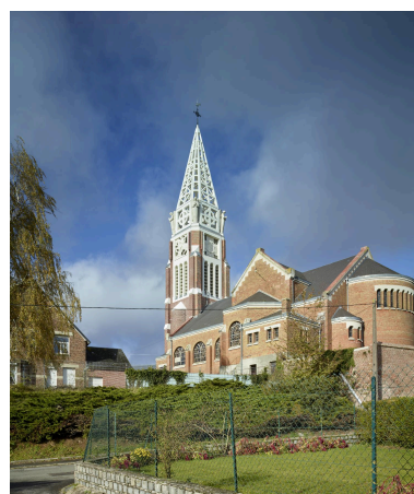
Vue générale de l'église avec le chevet et le mur sud. Vue orientée est - ouest. Phot. Pierre Thibaut IVR32_20235900928NUCA
