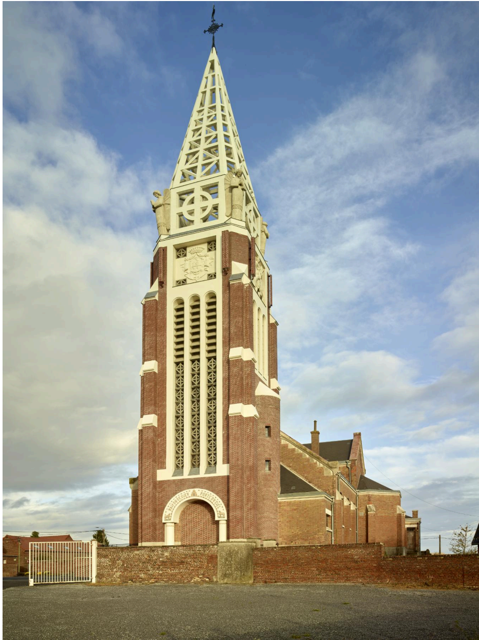
Vue générale de la façade ouest et du mur sud, avec les claustra en béton en partie basse du clocher.
