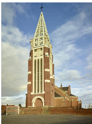
Vue générale de la façade ouest et du mur sud, avec les claustra en béton en partie basse du clocher. Phot. Pierre Thibaut IVR32_20235900936NUCA
