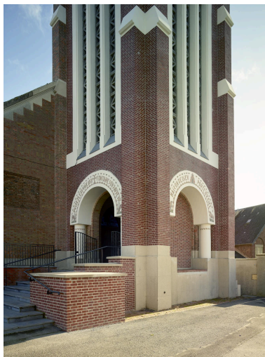
Vue de détail des deux premiers niveaux du clocher- porche côtés nord et ouest. Phot. Pierre Thibaut IVR32_20235900930NUCA
