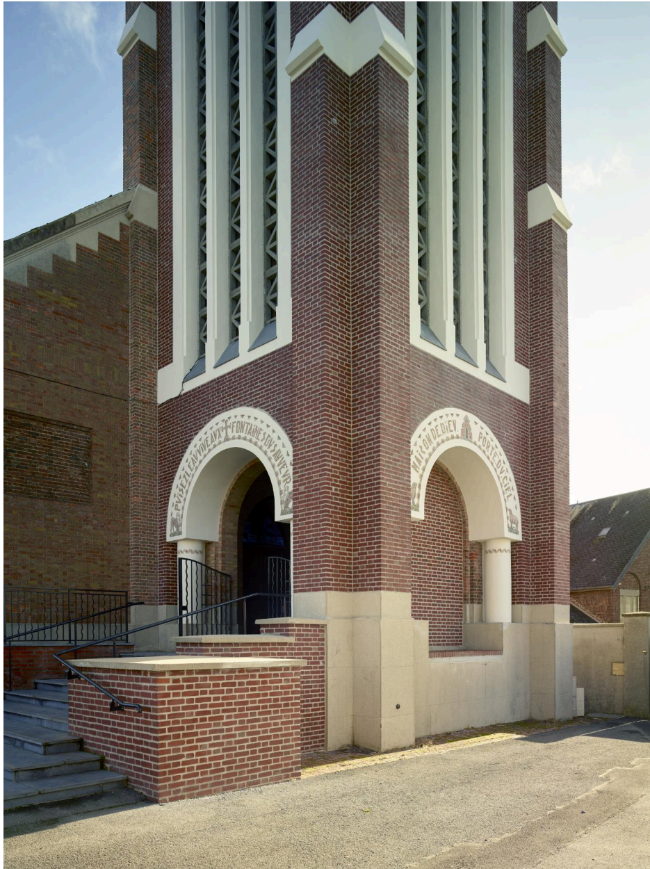
Vue de détail des deux premiers niveaux du clocher-porche côtés nord et ouest.
