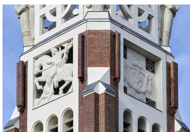
Vue de détail des panneaux sculptés du clocher-porche représentant "la Charité de Saint-Martin" et les armes de la ville réalisés par Marcel Bouraine. Phot. Pierre Thibaut IVR32_20235900851NUCA
