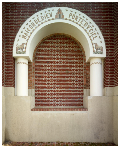
Vue de détail de l'arc aveugle du premier niveau du clocher-porche côté ouest. Phot. Pierre Thibaut IVR32_20235900931NUCA
