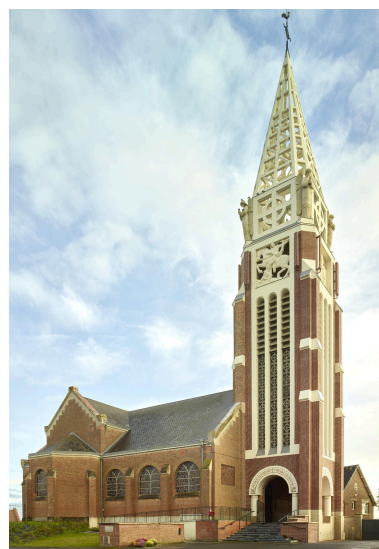
Vue générale de l'église avec le clocher-porche et le mur nord. Vue orientée nord - sud. Phot. Pierre Thibaut IVR32_20235900934NUCA
