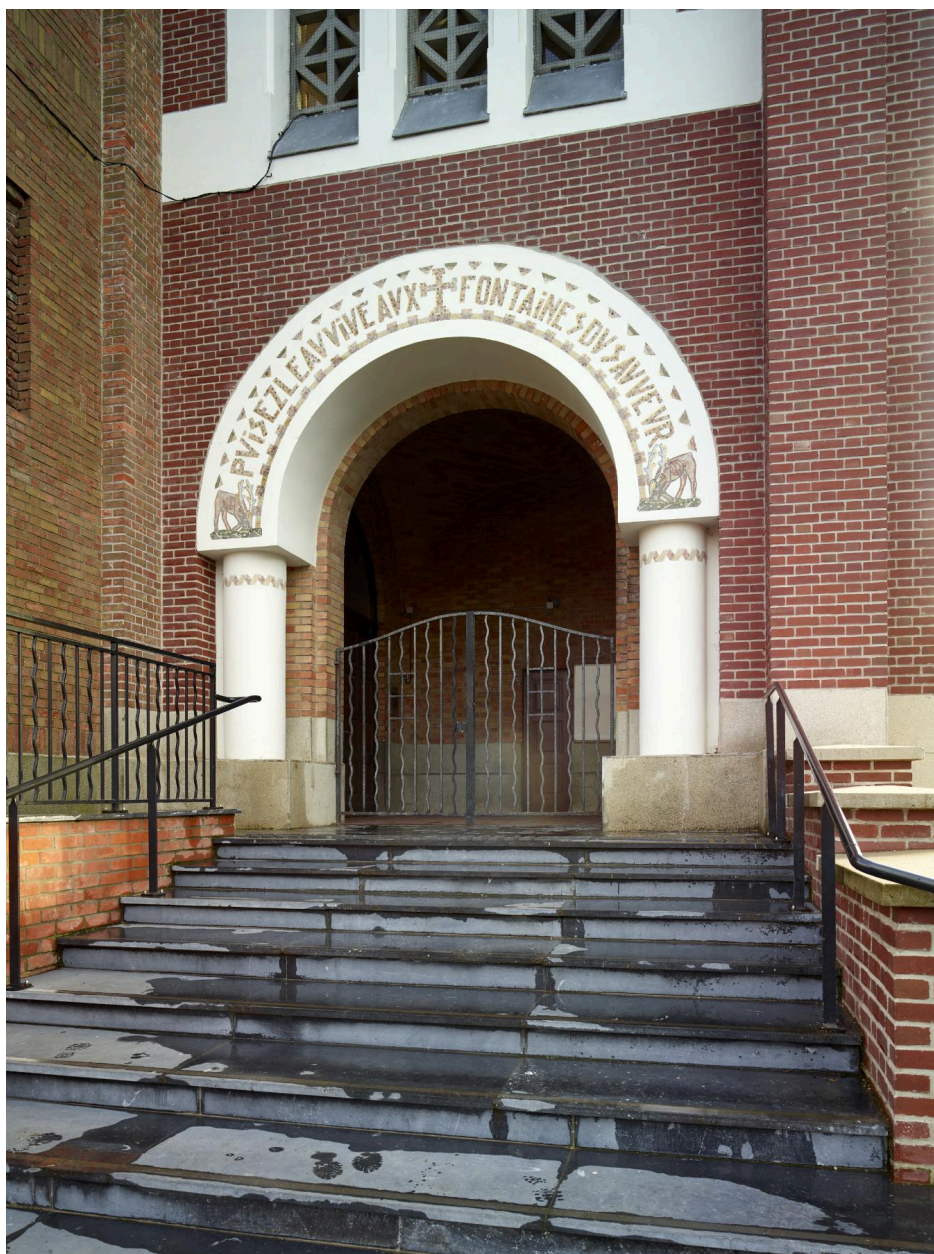
Vue de détail de l'arc du premier niveau du clocher-porche côté nord.
