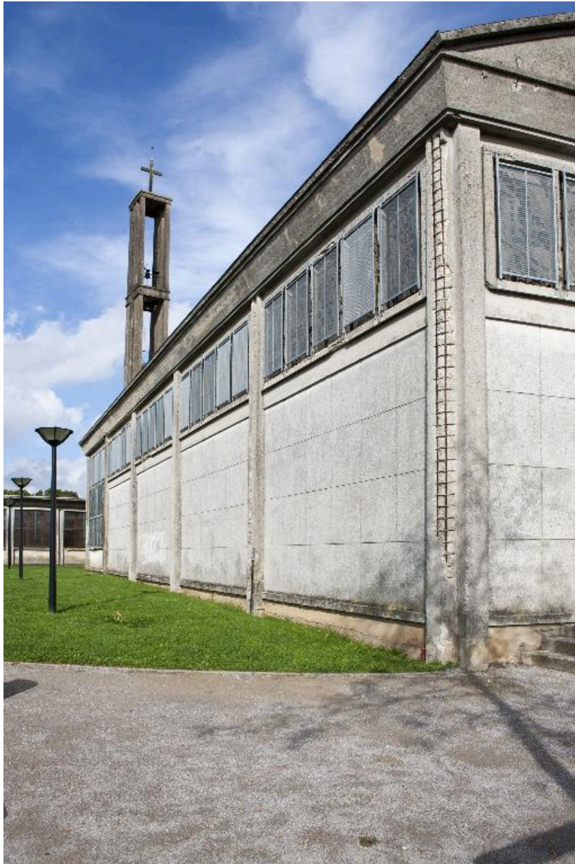
Élévation du flanc gauche de l'église.
