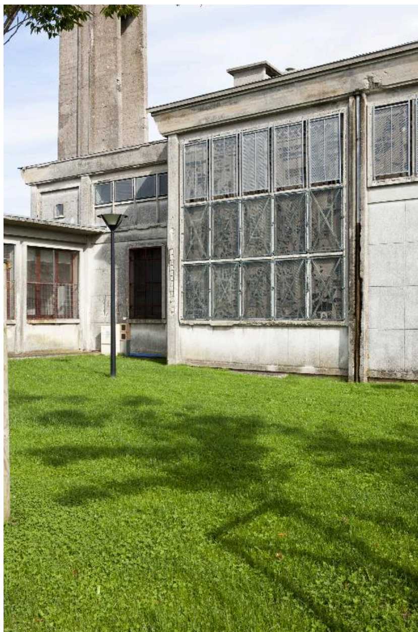
Vue extérieure de la verrière du flanc gauche.
