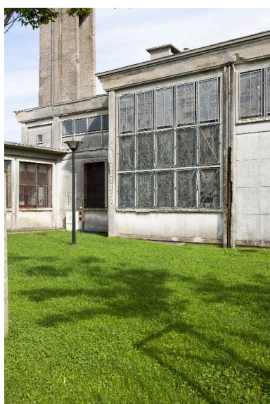
Vue extérieure de la verrière du flanc gauche. Phot. Pierre Thibaut IVR31_20155900073NUCA
