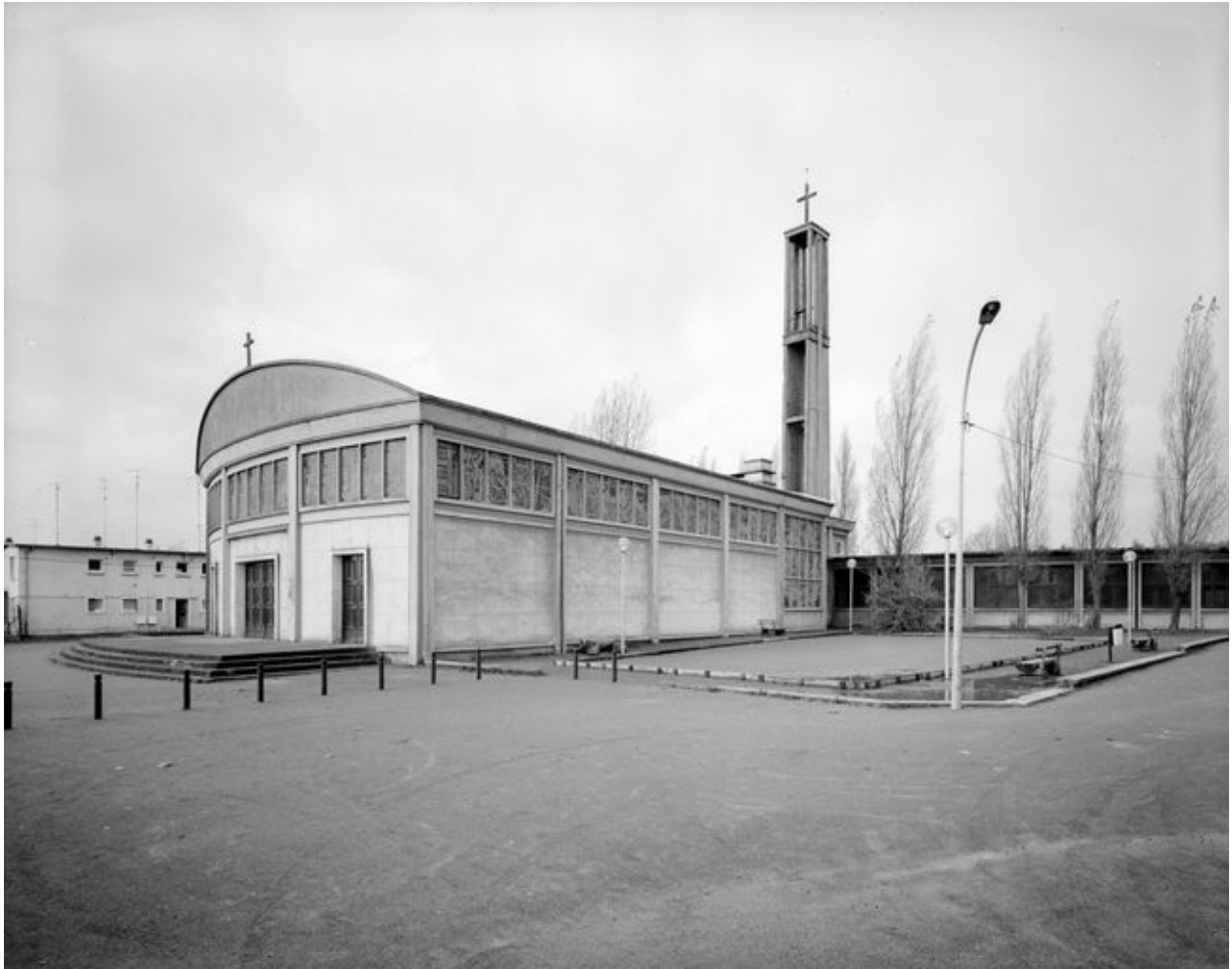
Vue des façades sud et est.
