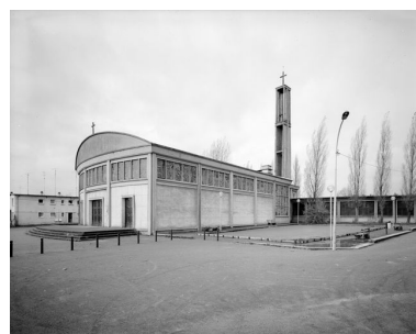
Vue des façades sud et est. Phot. Olivier Marlard IVR31_19925901661V
