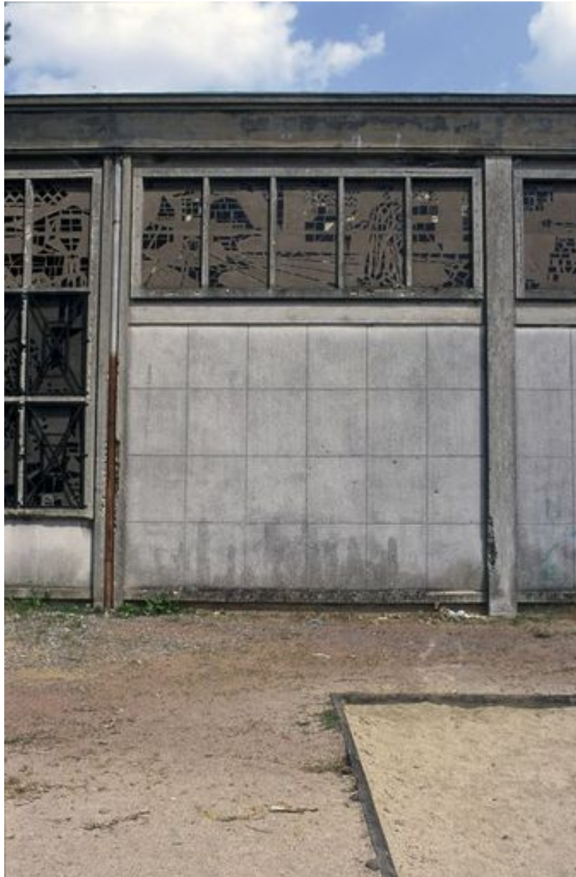
Vue partielle de l'élévation ouest.
