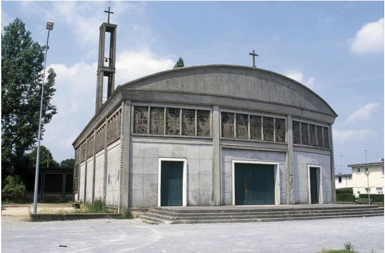
Vue générale des élévations ouest et sud.
