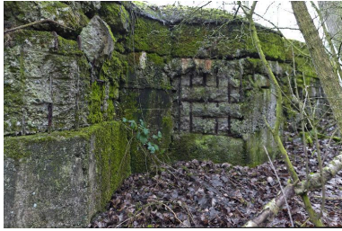
Elévation nord-est Phot. Jean-Marc Ramette IVR31_20145904418NUCA
