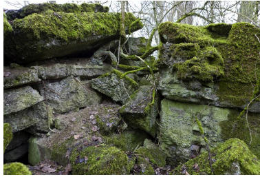
Elévation nord-est Phot. Jean-Marc Ramette IVR31_20145904420NUCA
