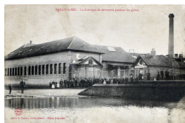
La fabrique de serrurerie pendant les grèves, carte postale, cliché Delenclos (coll. part.). Repro. Thierry Lefébure IVR32_20258002119NUCA
