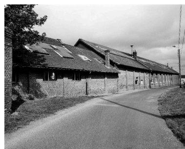
Atelier de fabrication est, vue d'ensemble. Phot. Benoît Dufournier IVR22_19888000959X
