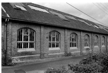
Atelier de fabrication, vue partielle, flanc est. Phot. Benoît Dufournier IVR22_19888001107Z
