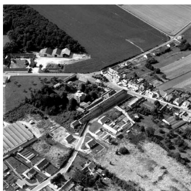
Vue aérienne, flanc sud-est. Phot. Phot'R IVR22_19888001471P
