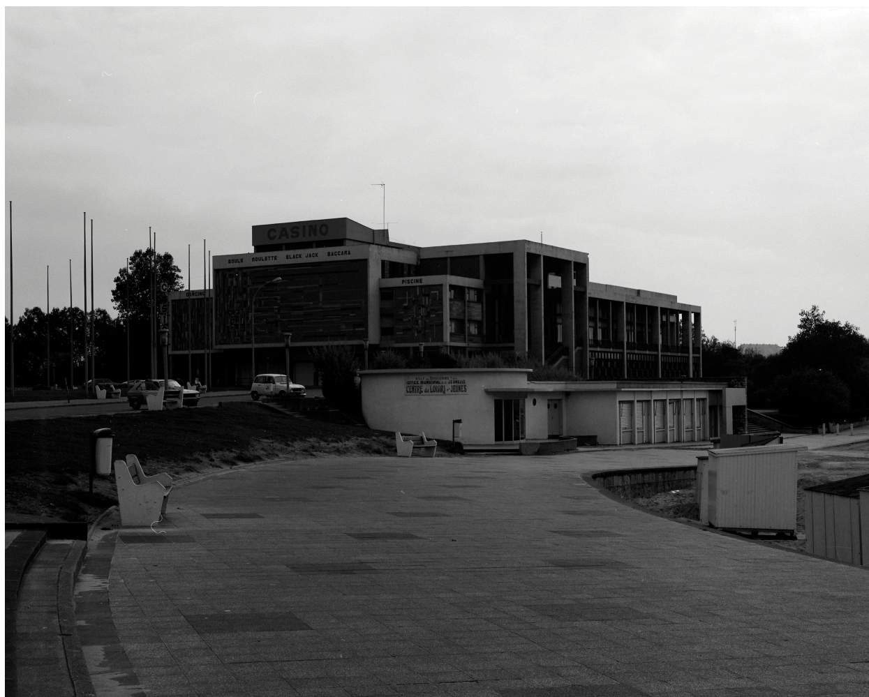
Casino municipal, vue générale d'angle nord.
