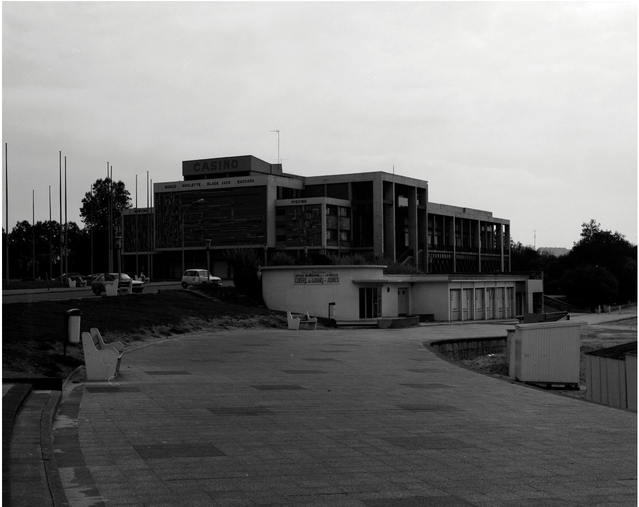
Casino municipal, vue générale d'angle nord.
