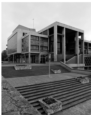
Casino municipal, angle nord. Phot. Philippe Caudroit IVR31_19846200219X
