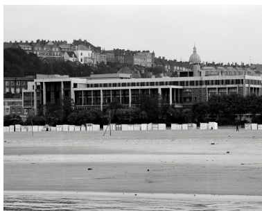
Casino municipal, façade nord-ouest sur rivage. Phot. Philippe Caudroit IVR31_19846200221X
