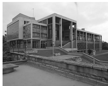
Casino municipal, façade nord-ouest, vue d'angle. Phot. Philippe Caudroit IVR31_19846200199X
