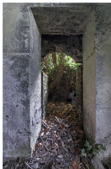
Couloir de sortie de l'édifice, vers le nord-ouest Phot. Jean-Marc Ramette IVR32_20166200258NUCA
