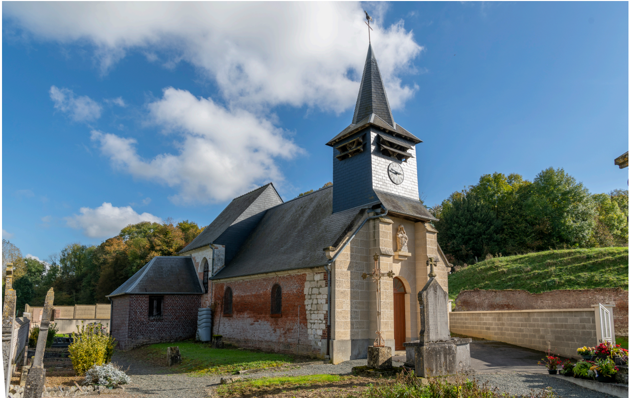
L'église entourée du cimetière, vue depuis l'ouest.
