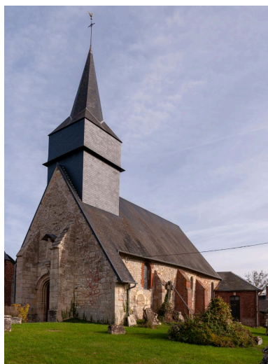
Vue de l'église depuis le nord-ouest.
