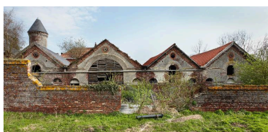
Vue générale des dépendances. Phot. Hubert Bouvet IVR31_20105900082NUCA
