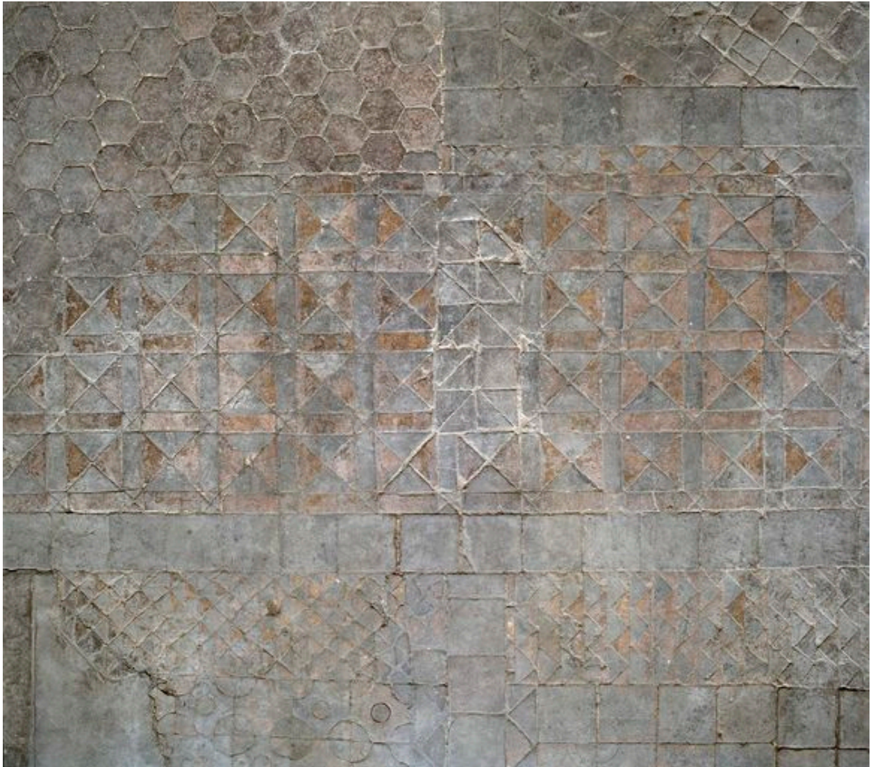
Détail du carrelage.
