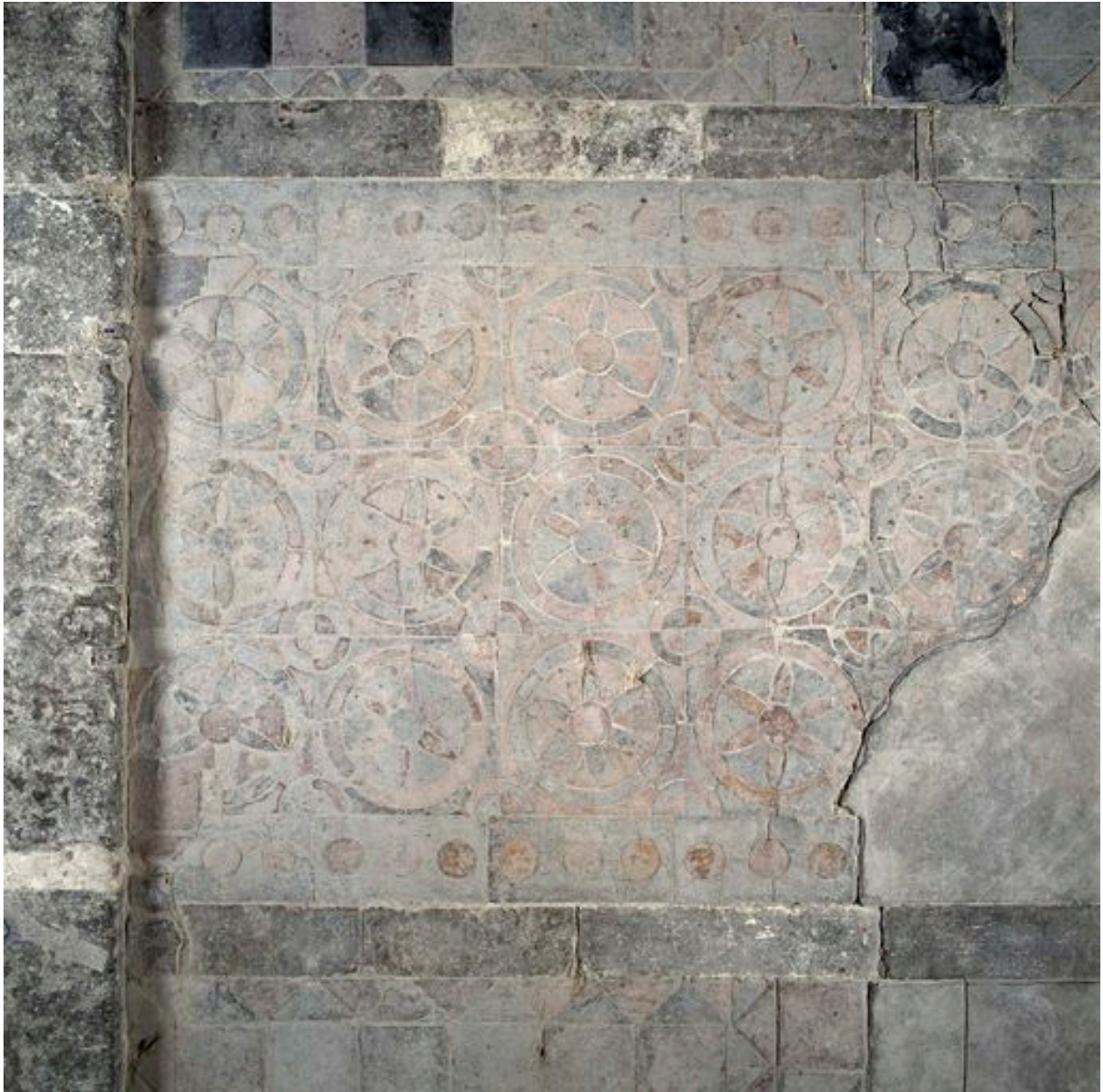
Détail du carrelage.
