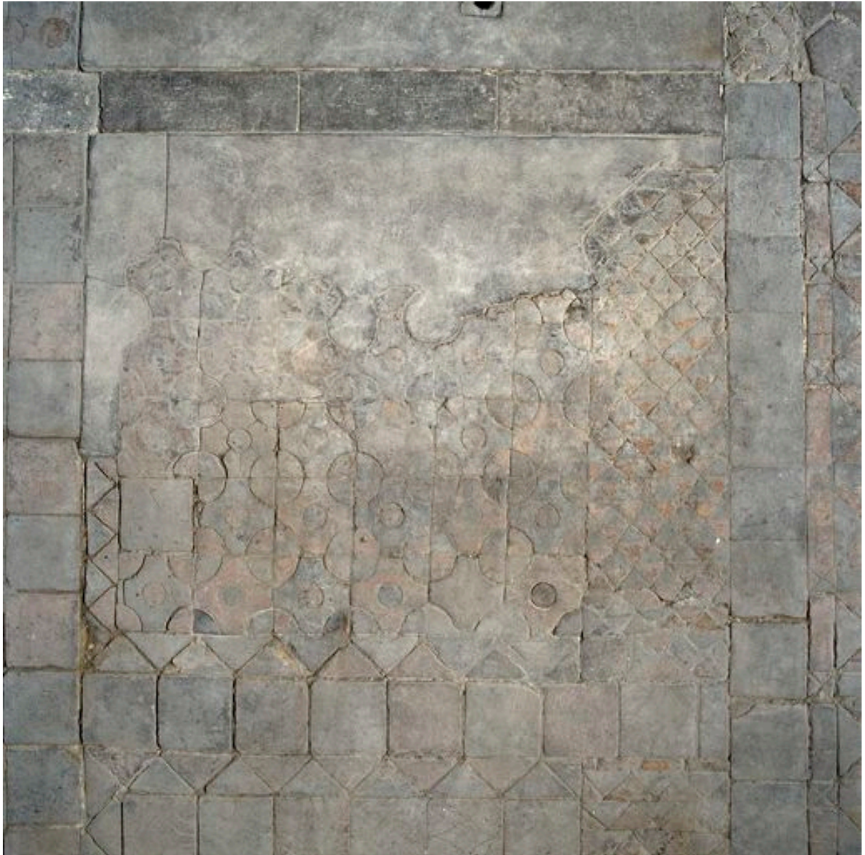
Détail du carrelage.
