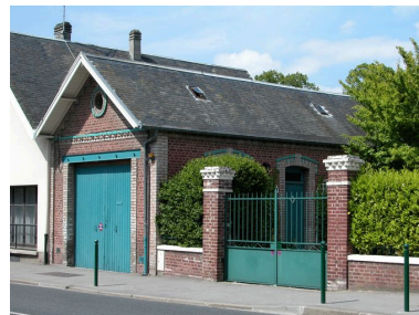
Le garage isolé, à l'aplomb du quai du Romerel. Phot. Elisabeth Justome IVR22_20058002866NUCA
