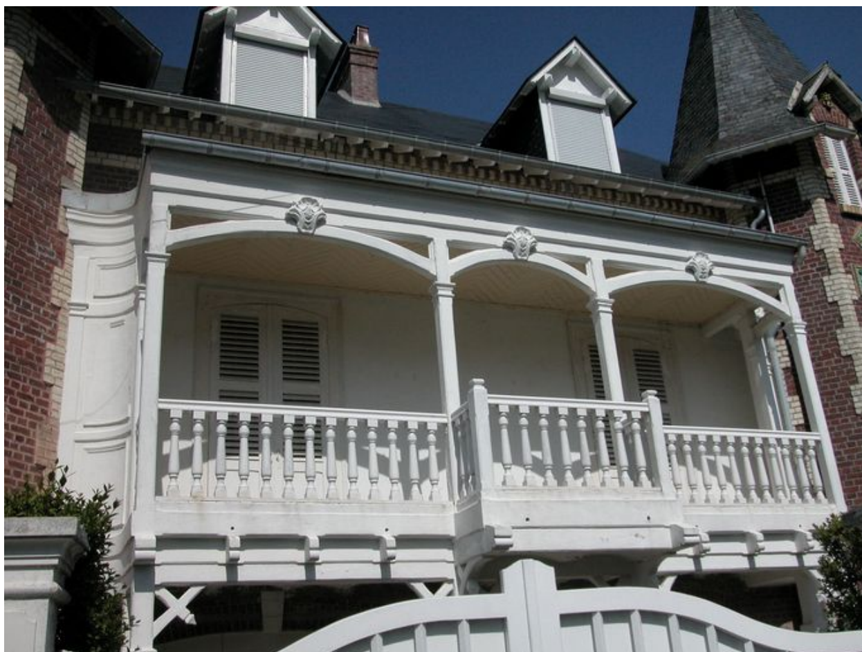
Détail du balcon couvert, façade antérieure.
