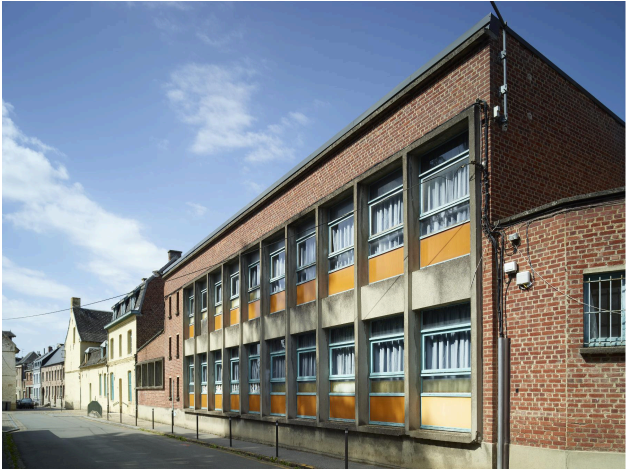
École de garçons : façade rue Chevray de l'aile construite dans les années 1960. Vue orientée ouest - est.
