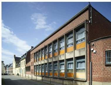
École de garçons : façade rue Chevray de l'aile construite dans les années 1960. Vue orientée ouest - est.
