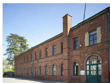
École de garçons : façade sur l'ancienne cour du collège du bâtiment construit en 1850 par l'architecte Casimir Pétiaux pour abriter les dortoirs du collège. Vue de détail de la partie nord-est, orientée sud-ouest/nord-est. Les remparts sont visibles à l'arrière-plan. Phot. Pierre Thibaut IVR32_20255900160NUCA
