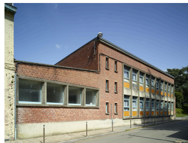
École de garçons : façade rue Chevray, construite dans les années 1960. Vue orientée est - ouest.
