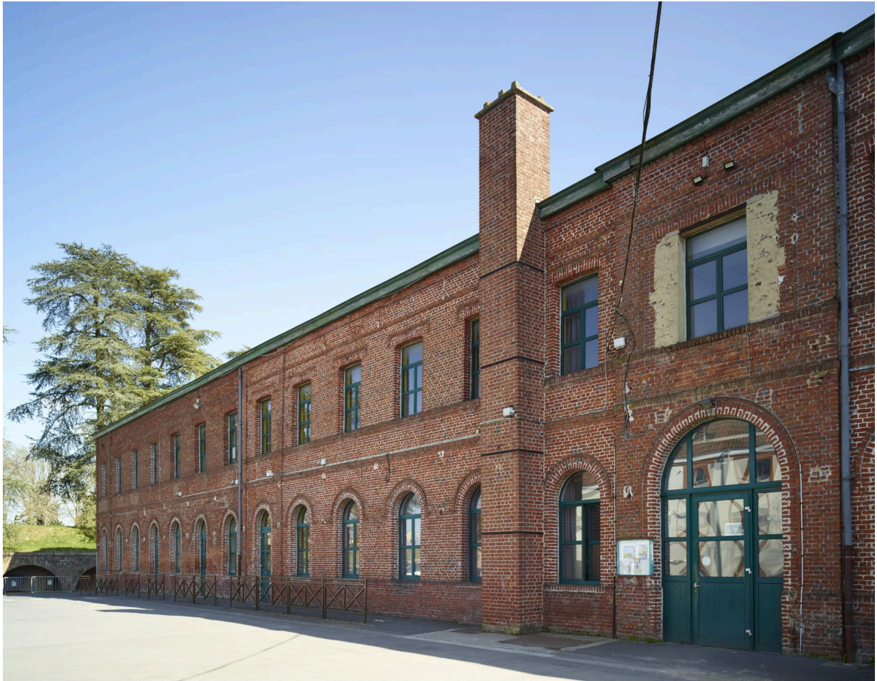
École de garçons : façade sur l'ancienne cour du collège du bâtiment construit en 1850 par l'architecte Casimir Pétaux pour abriter les dortoirs du collège. Vue de détail de la partie nord-est, orientée sud-ouest/nord-est. Les remparts sont visibles à l'arrière-plan.
