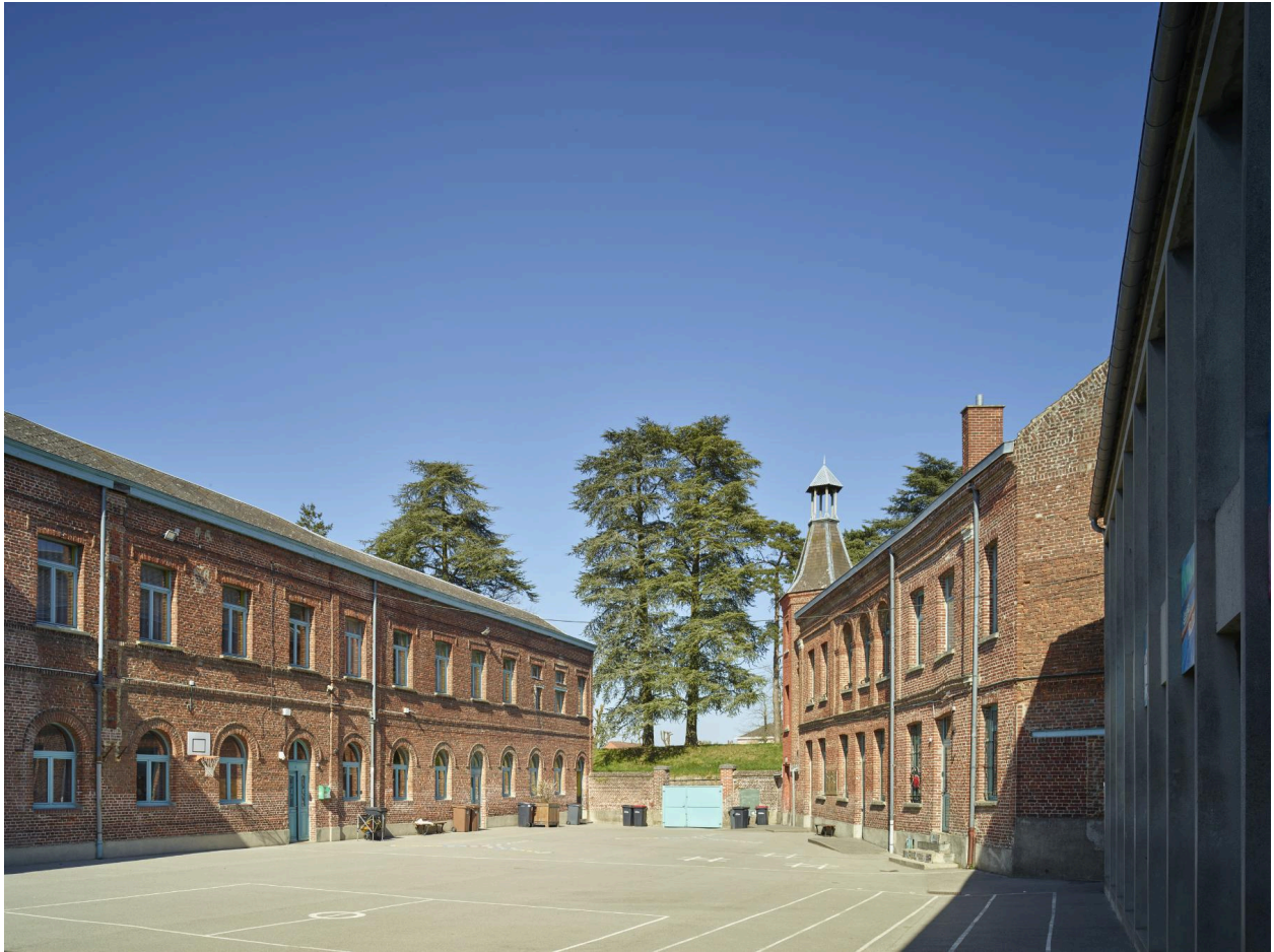
École de garçons : vue de la cour de l'école entre le bâtiment construit pour le collège en 1850 par Casimir Pétiaux (à gauche) et celui celui construit en 1879 par Félix Guillemain. Vue orientée sud-ouest/nord-est.
