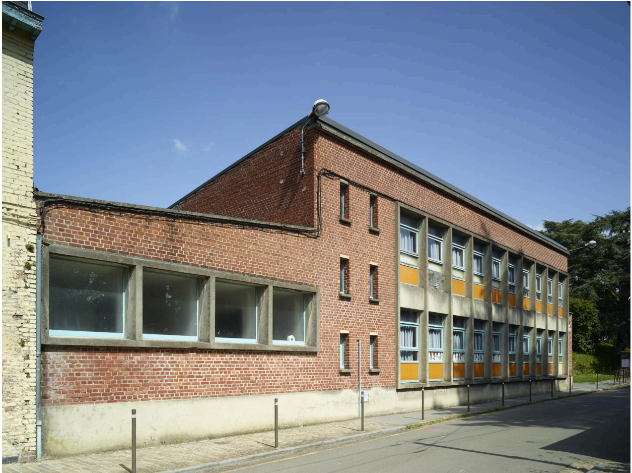
École de garçons : façade rue Chevray, construite dans les années 1960. Vue orientée est - ouest.
