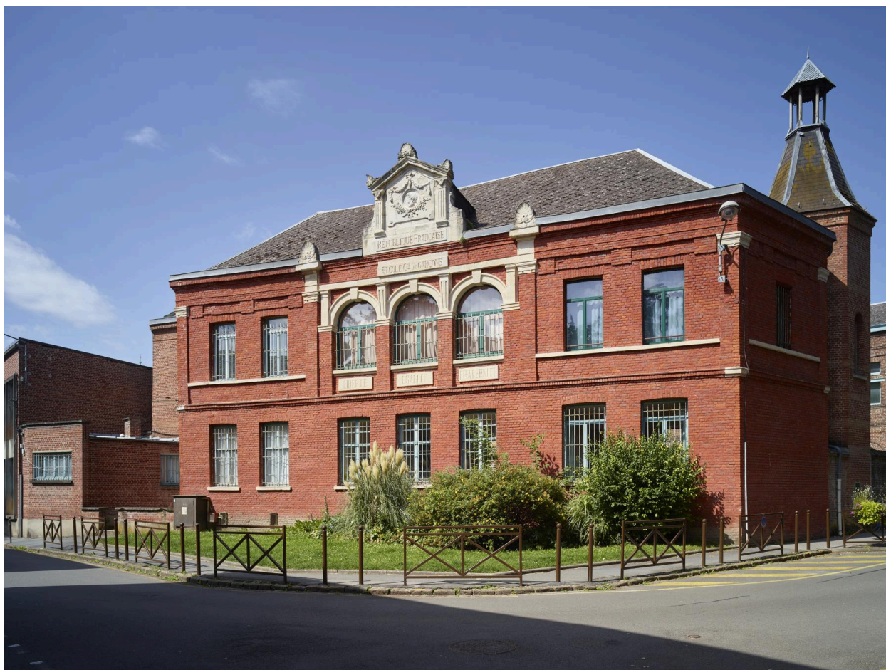
École de garçons : façade rue Chevray du bâtiment construit en 1879. Vue orientée nord-ouest/sud-est.
