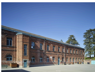
École de garçons : façade sur l'ancienne cour du collège du bâtiment construit en 1850 par l'architecte Casimir Pétiaux pour abriter les dortoirs du collège. Vue générale orientée sud-est/nord-ouest. Phot. Pierre Thibaut IVR32_20255900167NUCA
