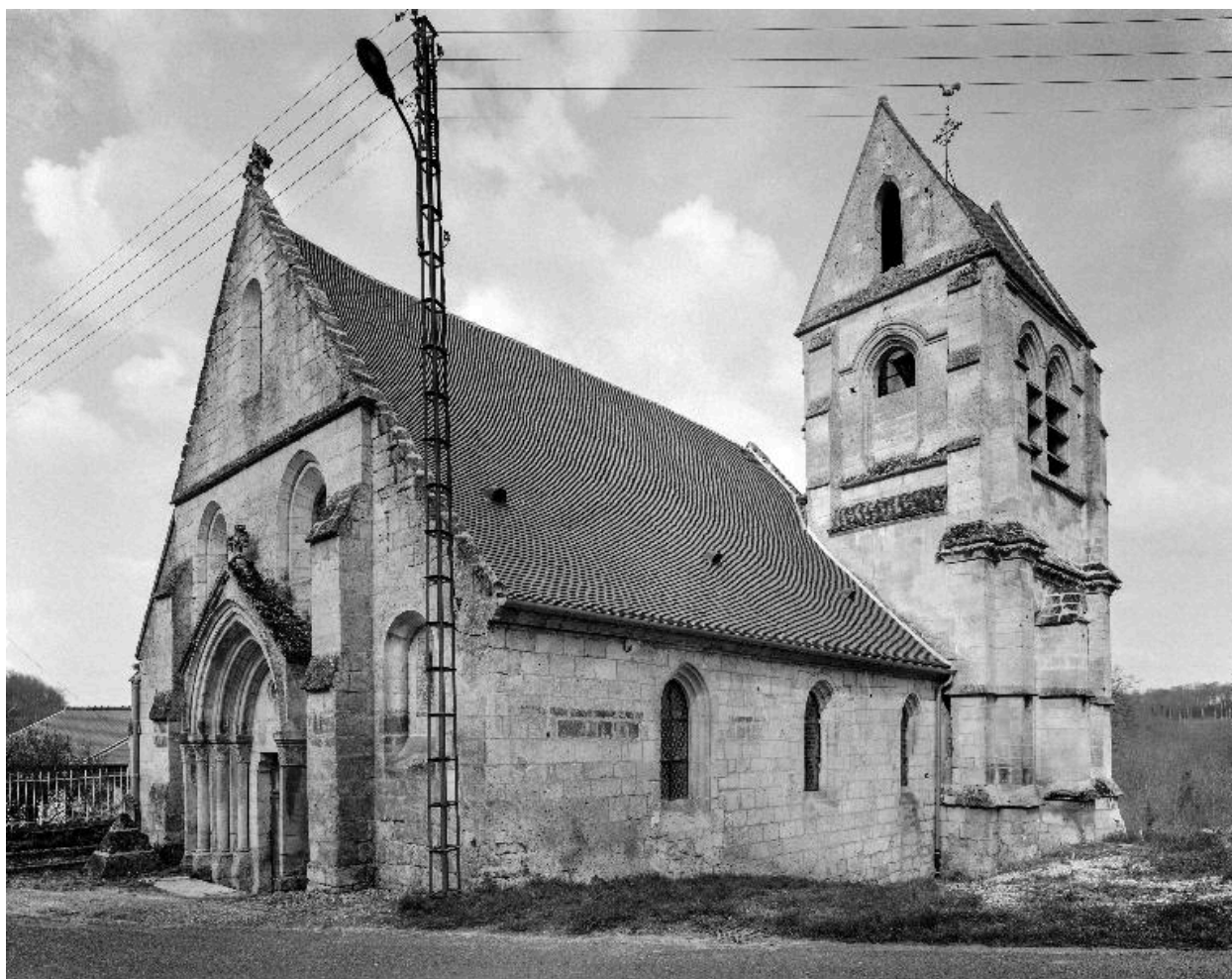
Vue générale sud-ouest de l'église.
