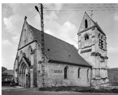
Vue générale sud-ouest de l'église. Phot. Fabrice Charrondière IVR22_19860200350V
