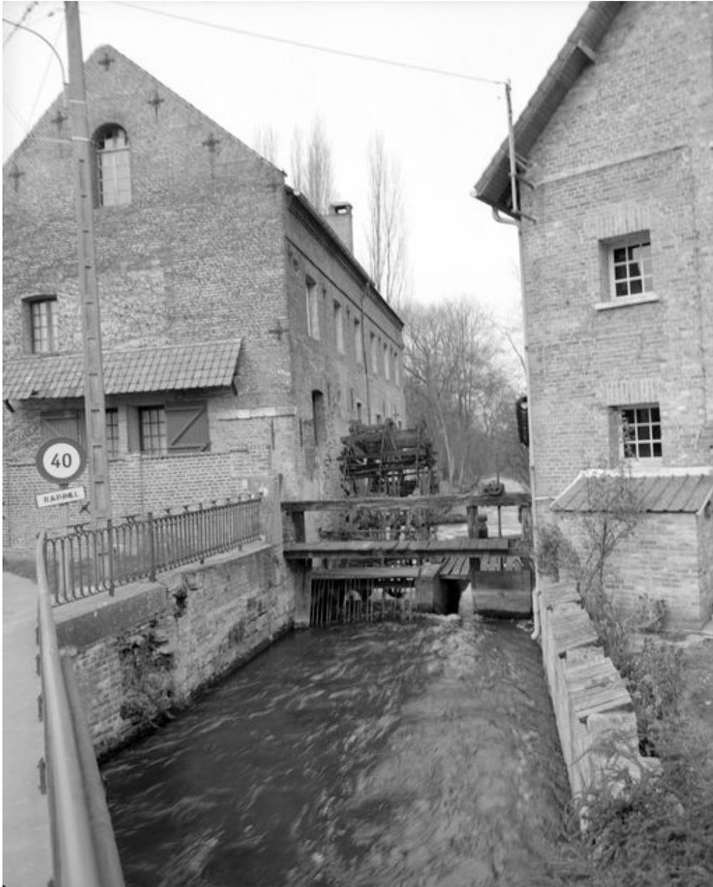
Atelier de fabrication, roue hydraulique verticale, vanne.
