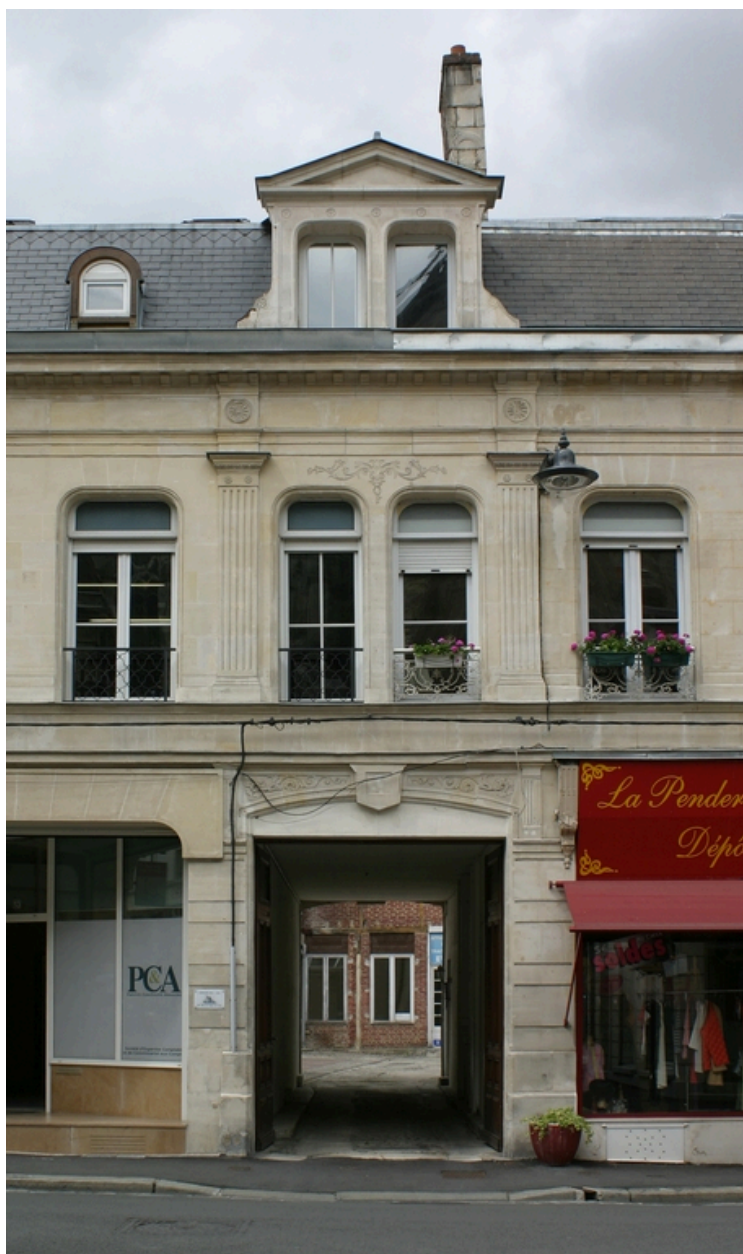
Travée centrale de la façade antérieure : porte cochère donnant accès à la cour, aux anciens magasins et ateliers.
