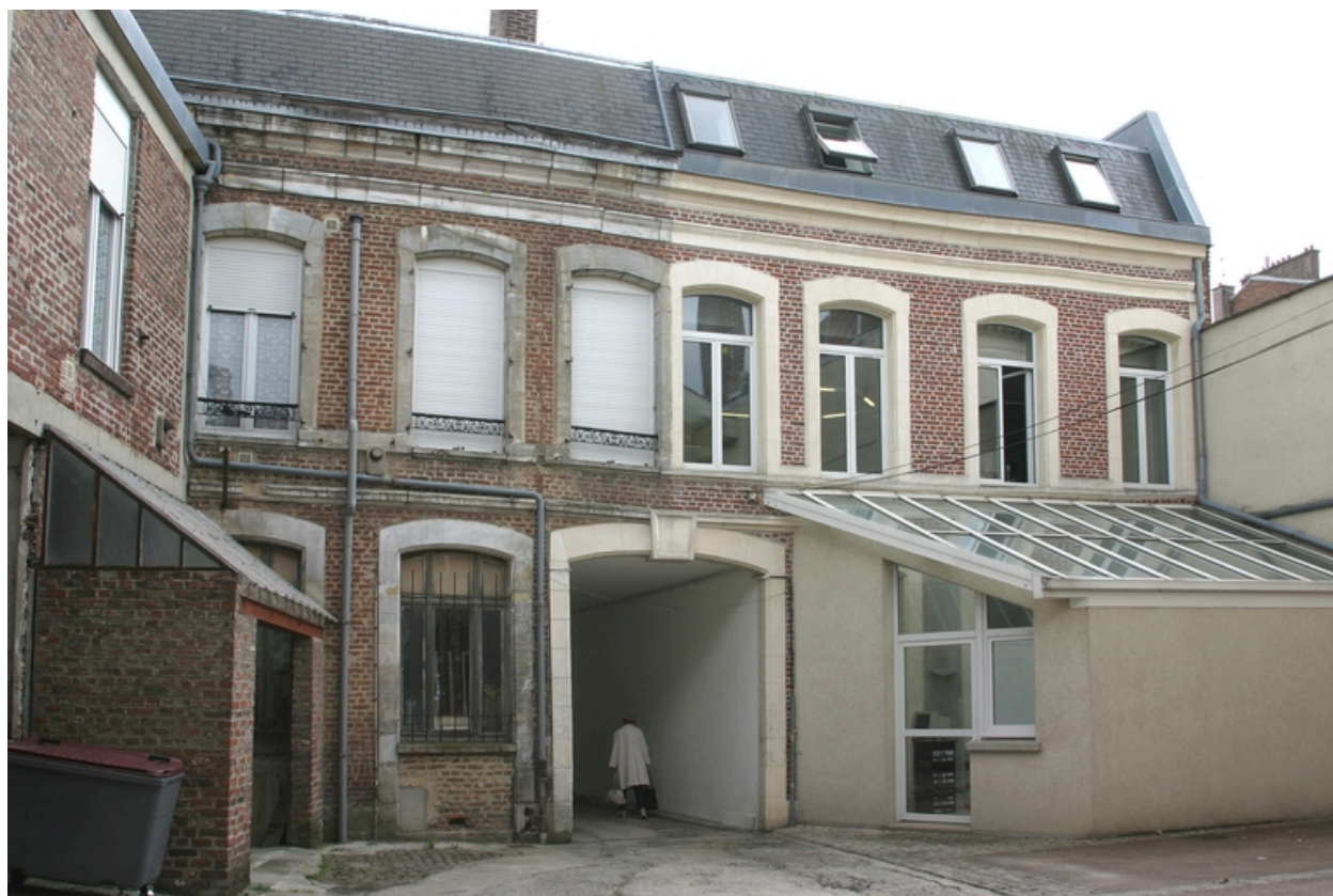
Façade postérieure des anciens logements patronaux.
