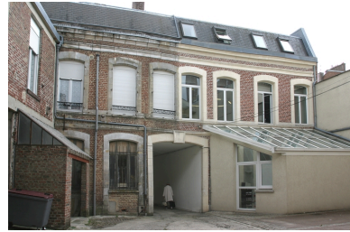
Façade postérieure des anciens logements patronaux. Phot. Frédéric Pillet IVR22_20050206118NUCA
