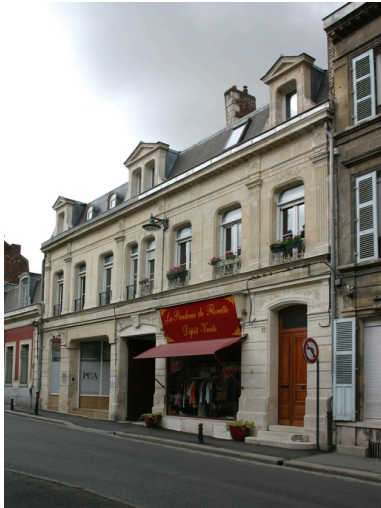
Façade antérieure des anciens logements patronaux. Phot. Frédéric Pillet IVR22_20050206117NUCA
