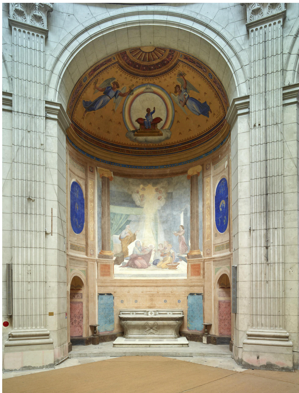
Vue générale, après restauration.
