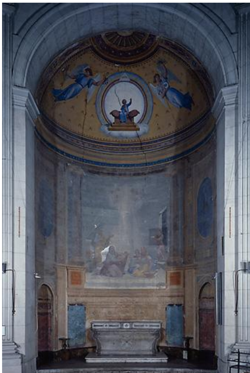
Vue générale, avant restauration.
