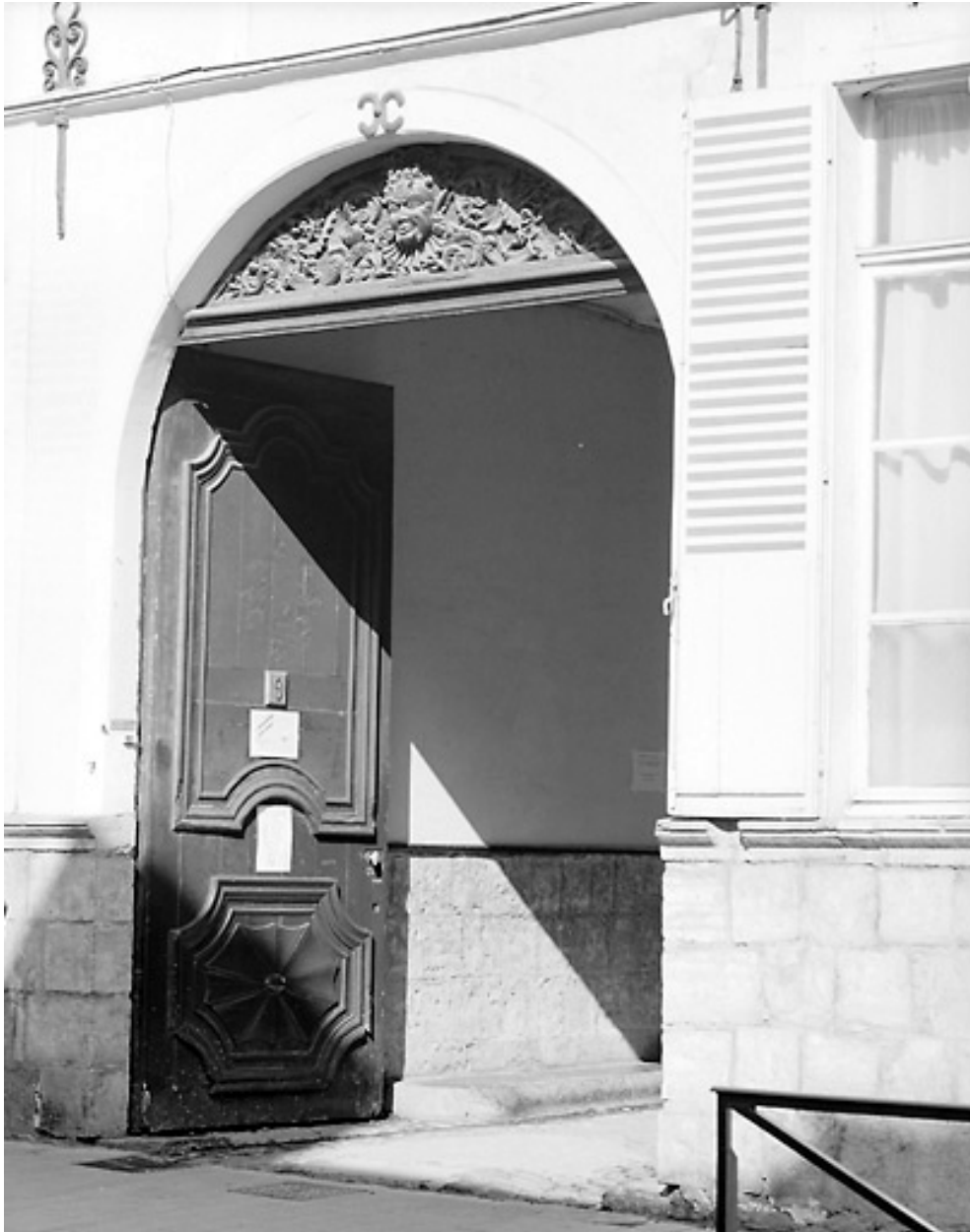
Façade rue Notre-Dame, porte cochère : vue générale.
