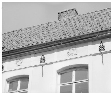
Façade rue Notre-Dame, vue partielle : table sculptée et cartouche des travées 5 et 6. Phot. Pierre Thibaut IVR31_20015901227X
