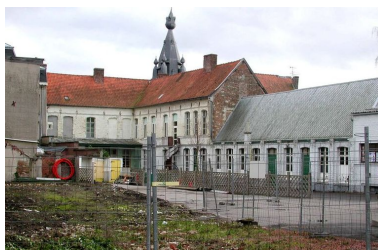
Vue depuis la rue Neuve : façade arrière, aile en retour, aile de la cantine, cour. Phot. Anita Oger-Leurent IVR31_20065906202NUCA
