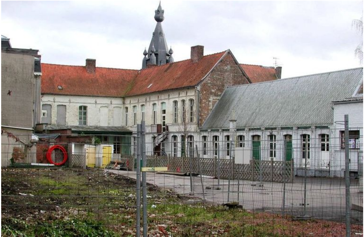
Vue depuis la rue Neuve : façade arrière, aile en retour, aile de la cantine, cour.
