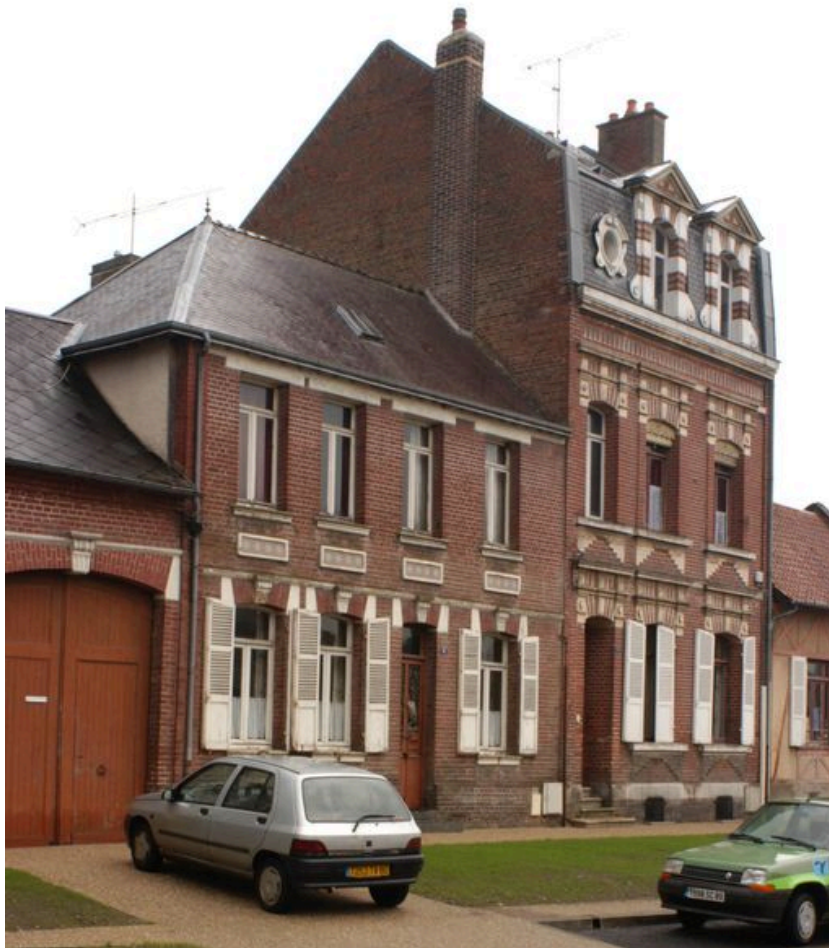
Vue partielle, depuis le nord-est.
