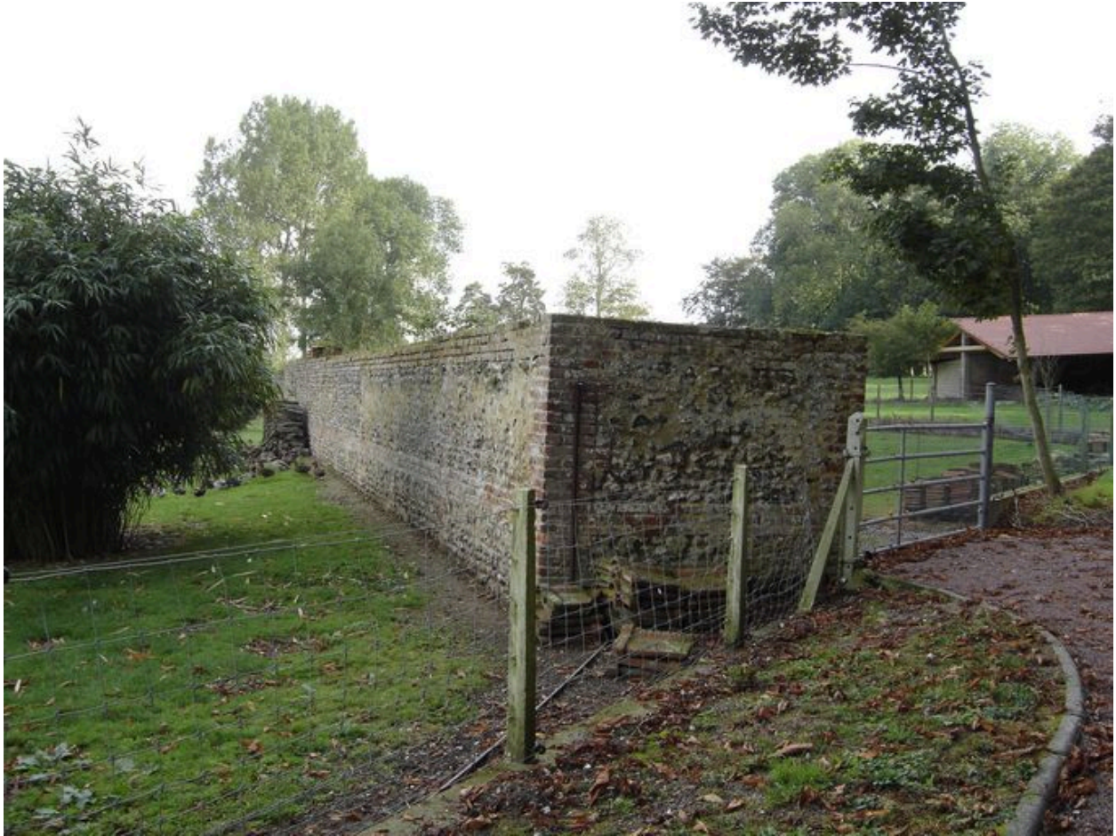
Vue de la clôture du mur du jardin.
