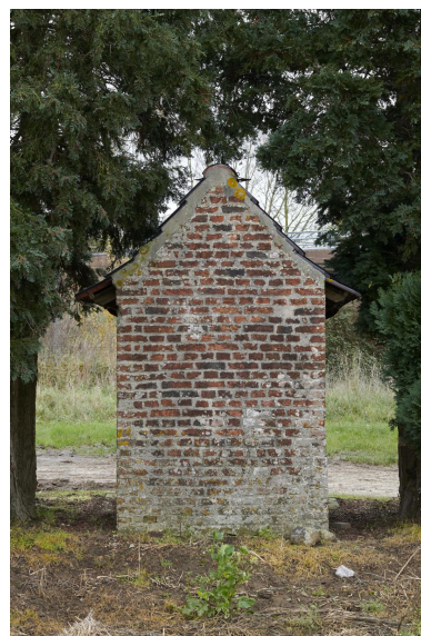
Détail de l'arrière de la chapelle. Phot. Delphine Volto Jourdan IVR32_20245902622NUCA
