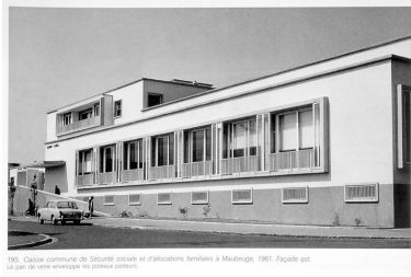
Élévation est du bâtiment abritant la Sécurité Sociale et les Allocations Familiales, Duprat photographie (archives C.A. Lurçat), 1961. Dans : JOLY Robert, JOLY Pierre. L'architecte André Lurçat. Paris : Picard, 1995, p. 201. Phot. Pierre Thibaut IVR31_20015902115ZB
