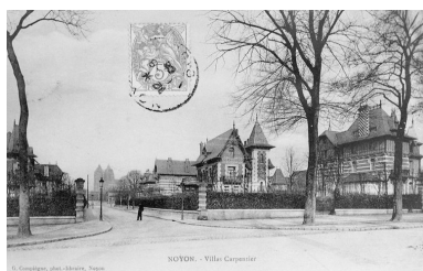
Boulevard Carnot et avenue Carpentier. Avant 1914 (AP). Phot. Jean-Michel Périn (reproduction) IVR22_19856000090XB
