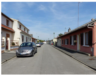
La rue d'Angleterre, vue depuis le sud. Phot. Isabelle Barbedor IVR32_20170205604NUCA
