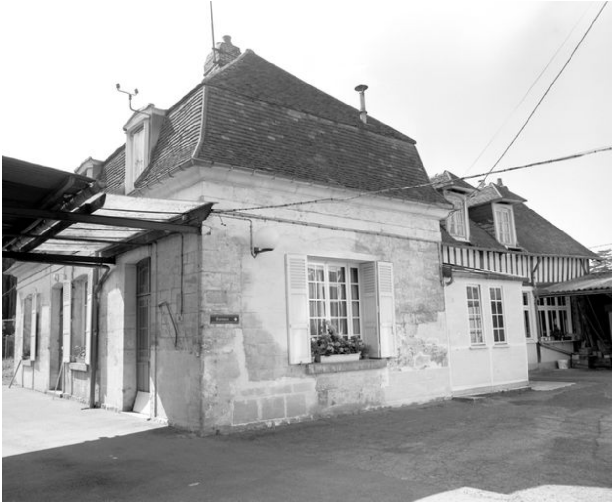
Le logement patronal et le bureau, façades donnant sur la cour.
