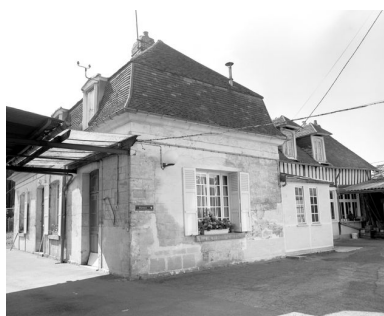
Le logement patronal et le bureau, façades donnant sur la cour. Phot. Laurent Jumel IVR22_19966002718X
