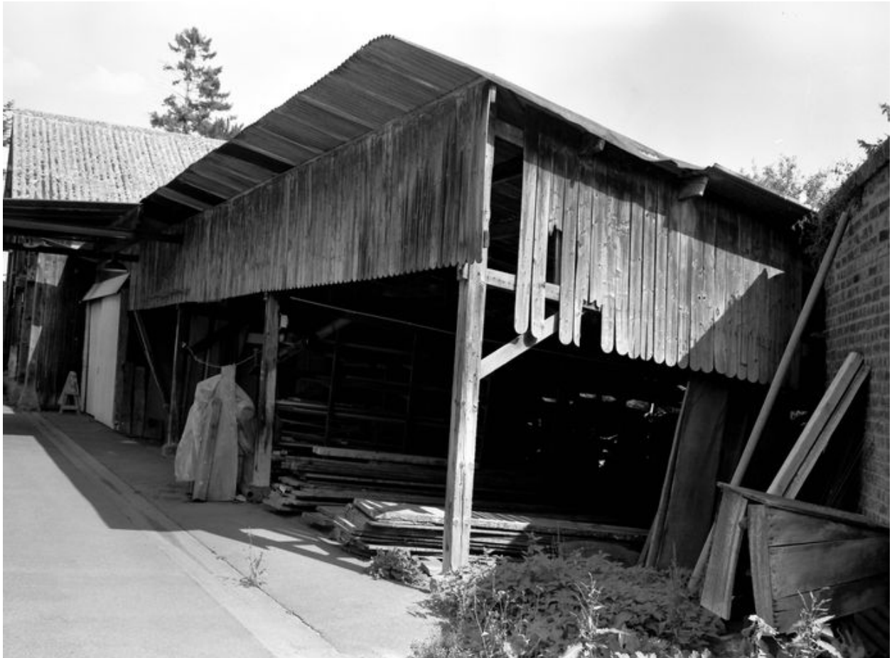
Entrepôt industriel, pignon nord-ouest.
