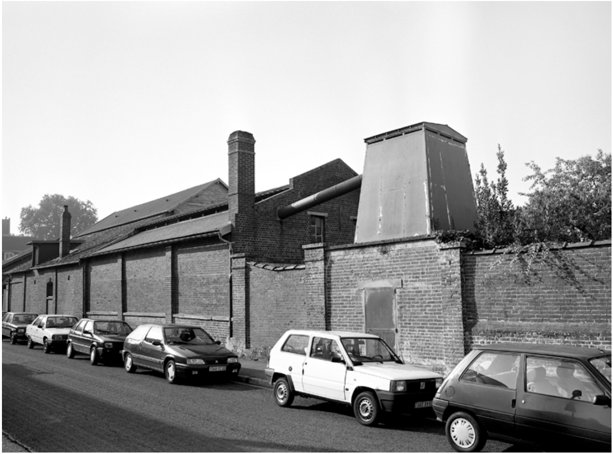
Vue latérale est-ouest des bâtiments de la menuiserie le long de la rue Caron avec, au premier plan, la chambres à copeaux.
