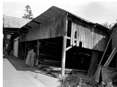
Entrepôt industriel, pignon nord-ouest. Phot. Laurent Jumel IVR22_19966002717X
