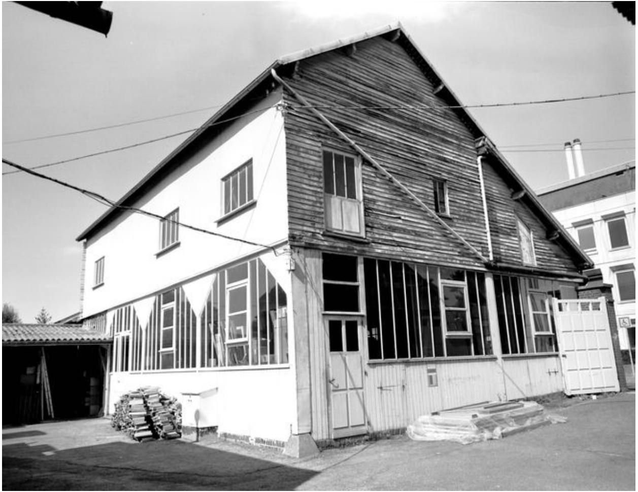
L'atelier de fabrication, pignon sud-est.
