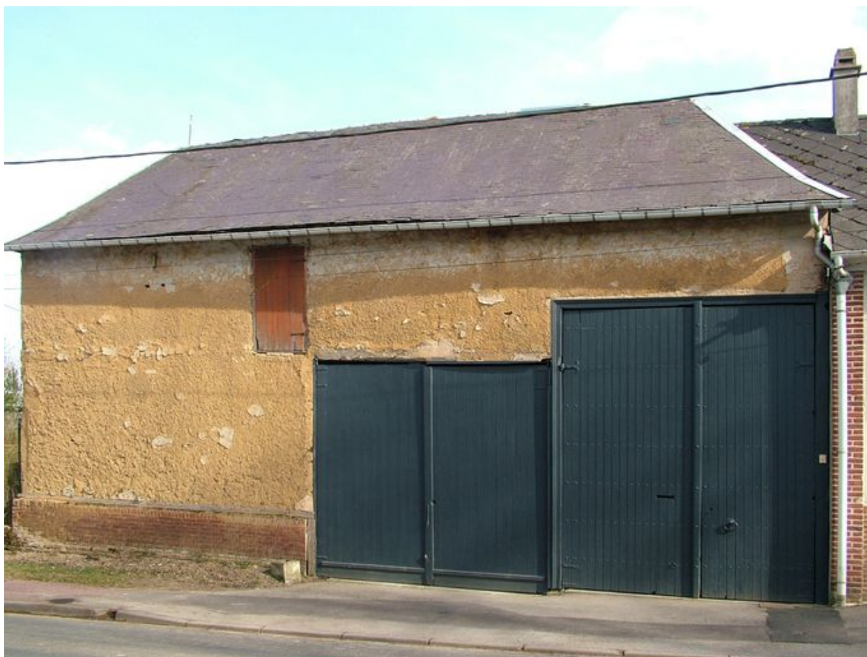
Grange et passage charretier.
