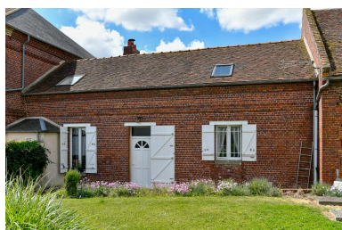
Logis des domestiques de ferme, vue depuis le nord. Phot. Marc Kérignard IVR32_20226000464NUCA
